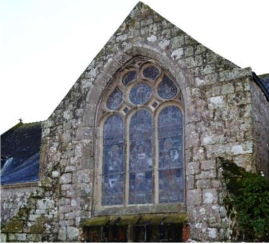
Fig. 59 - Pignon de la chapelle nord
