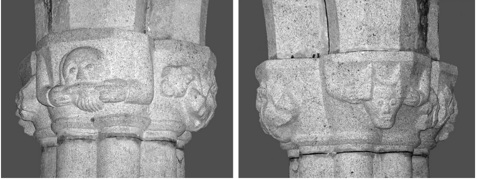
Fig. 13 - Chapiteaux des piliers du chœur
