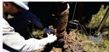
Inspecciones de Tanques de Almacenamiento de Combustibles
