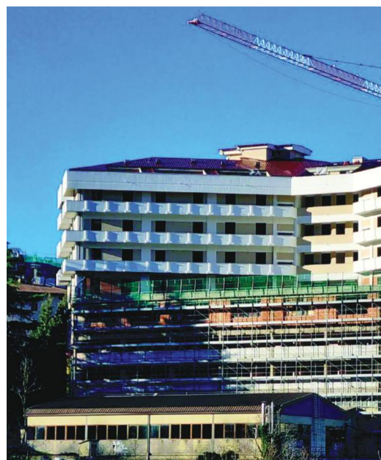
"ARCIDOSSO: futura nuova Sede Nazionale del Centro dell'Uomo OdV (ex Hotel Toscana in ristrutturazione)"
