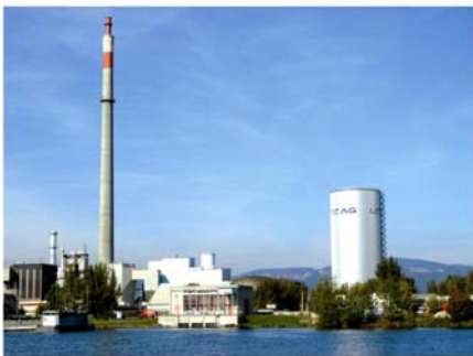
Fernheizkraftwerk Linz-Mitte: Optimale Brennstoffausnutzung dank modernster Kraft-Wärme-Kopplung.
