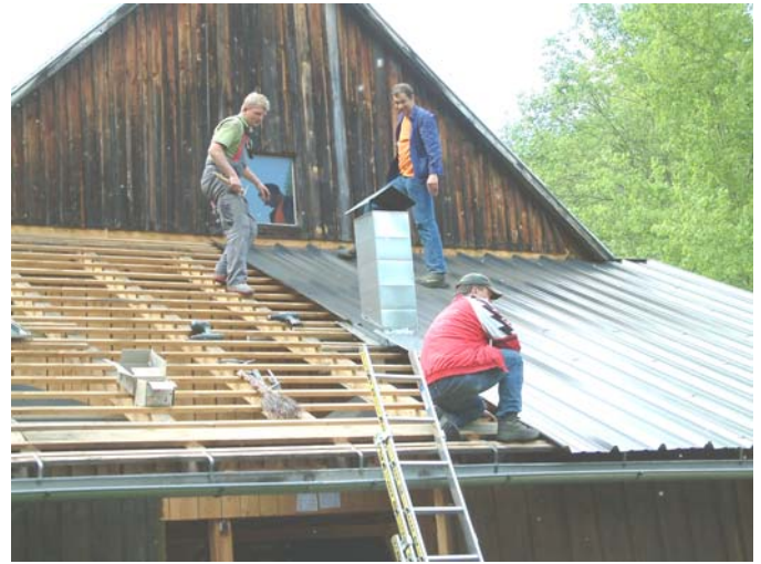
Erneuerung Teil des Stadeldaches - 2006
