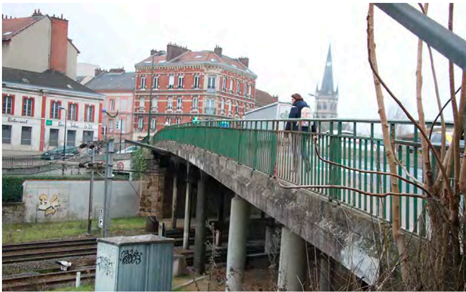
Les travaux du pont de la rue de Reims doivent s'achever en fin d'année. © l'Hebdo du Vendredi
