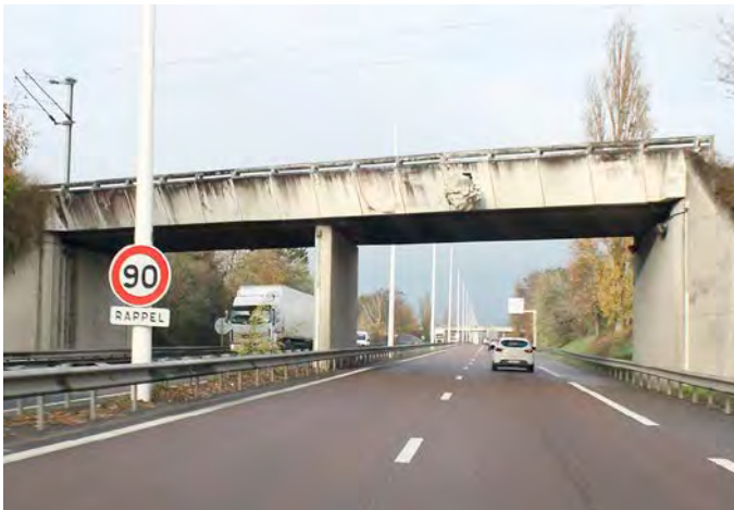
Les premiers travaux pour relier le boulevard des Tondeurs à l'A34 sont prévus en 2028. © l'Hebdo du Vendredi
