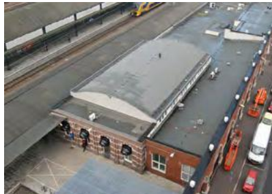
De kap die na het bombardement het puntdak vervangen heeft.
