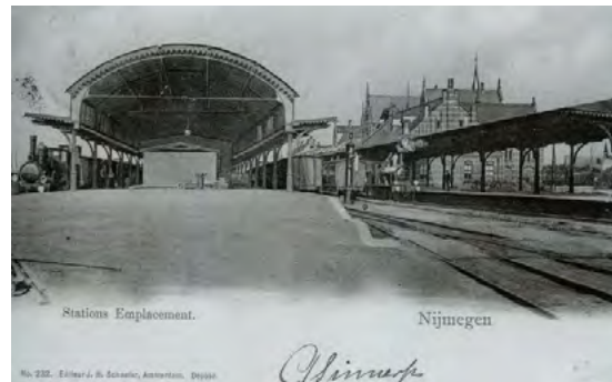
1904, de overkapping van perron 2. [SW]
