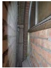
Dichtgemetselde bogen conserveren.
