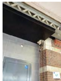
Aanhechting perronkap met de perrongevel en uitbouw.
