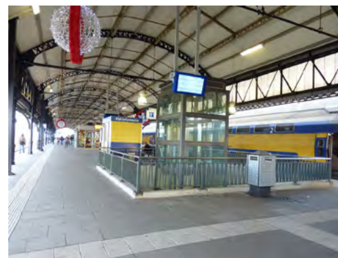
Nieuwe lift en trappartij.
