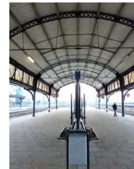
2011, oorspronkelijke constructie overkapping perron 2.
