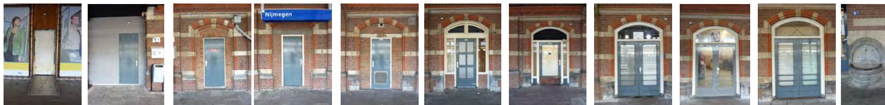
Enkele openingen in de perrongevel anno 2011
