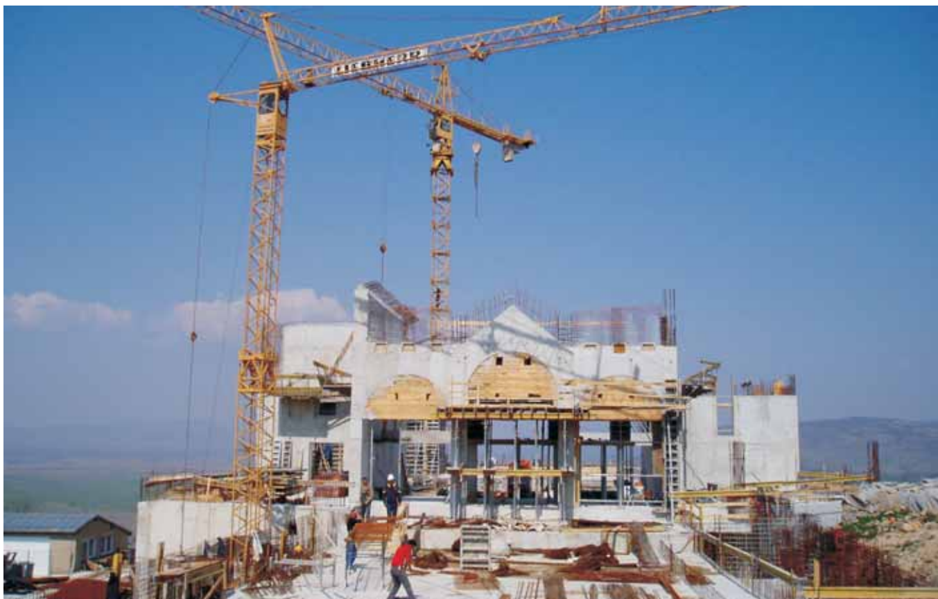
Napredovanje građevinskih radova
