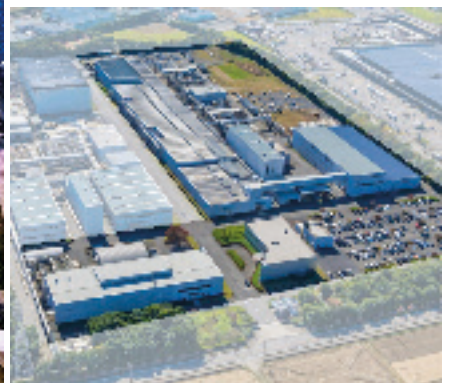
Kodak setzt mit seinen Werken in den USA, Europa und Japan auf regionale Versorgung seiner Druckplattenkunden. ✖ © . Kodak
