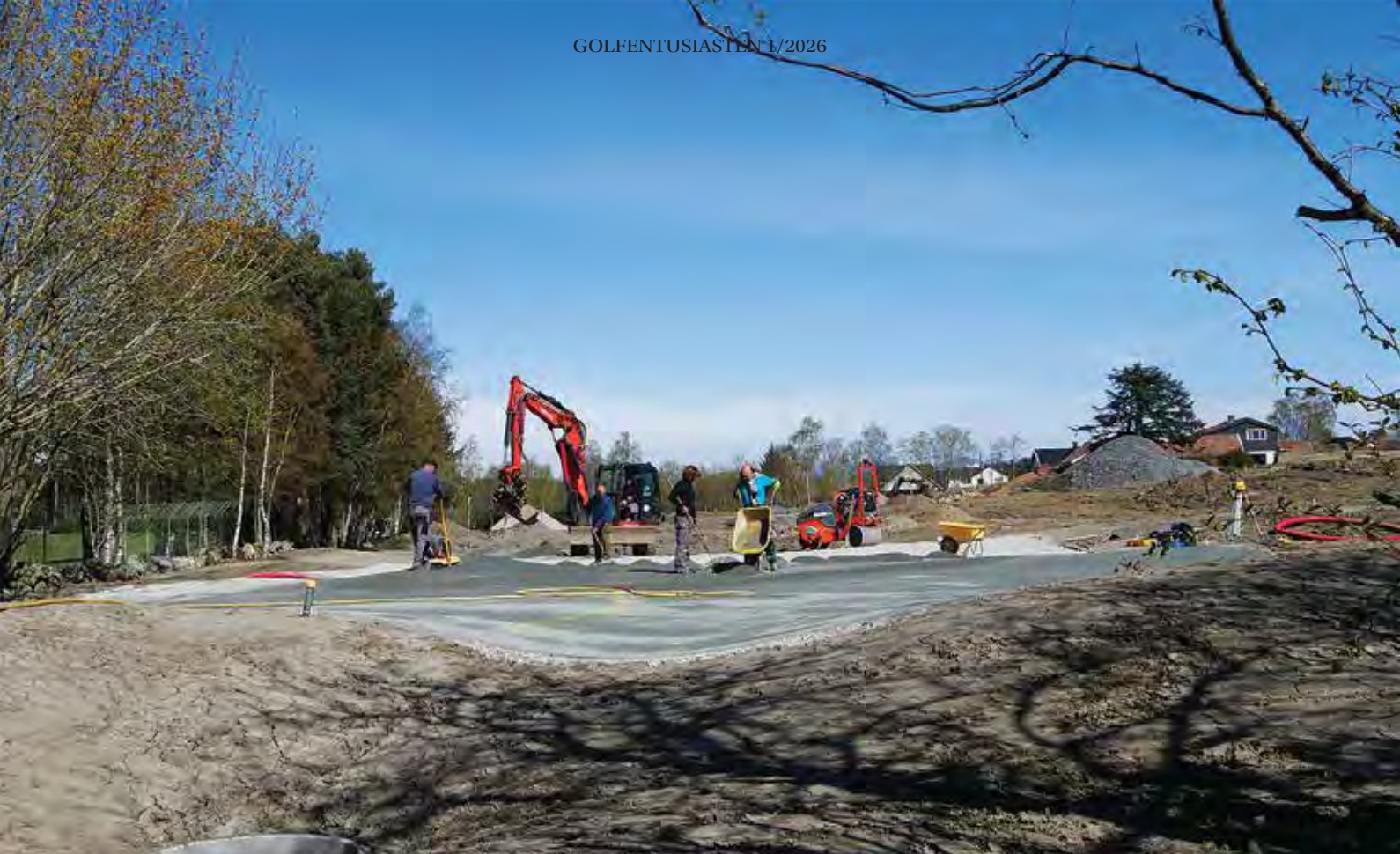
Sett fra hjørnet ved driving rangen 28. april: Arbeid på green 2 - Traseen til Lnettkablene går rett under der hvor arbeidet pågår.
