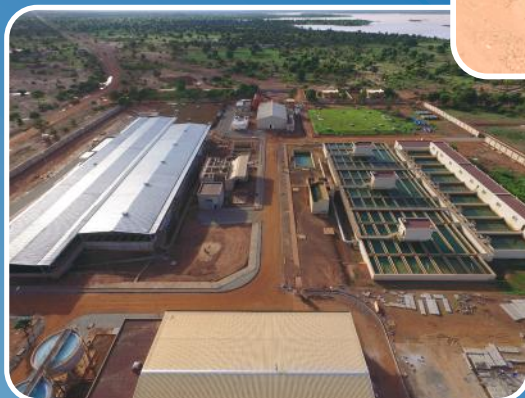
Vue aérienne de la station de traitement de Ziga
