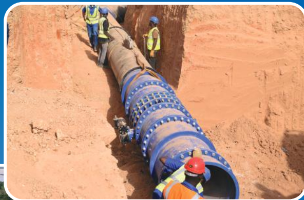
Pose de conduites d'amenée d'eau
