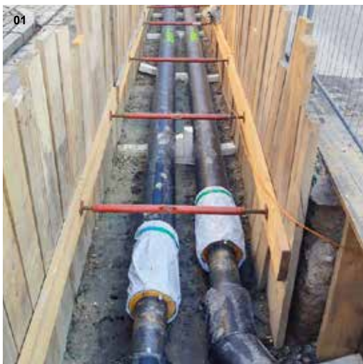
01 Fernwärme Geothermie, Braunau Simbach | Umlegung der Hauptleitung aufgrund der Errichtung eines Hochwasserschutzes
