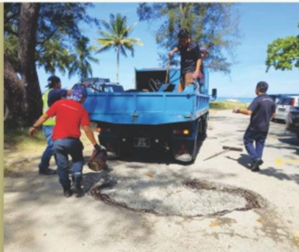
Kerja-kerja penyelenggaraan dan penampalan kawasan letak kereta di Tanjung Aru, pada 26 Mac 2024.
