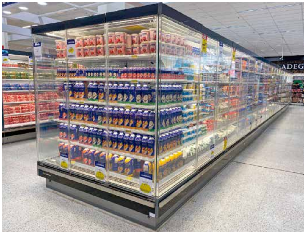
Expositor vertical de média temperatura (resfriados) fechado com portas
