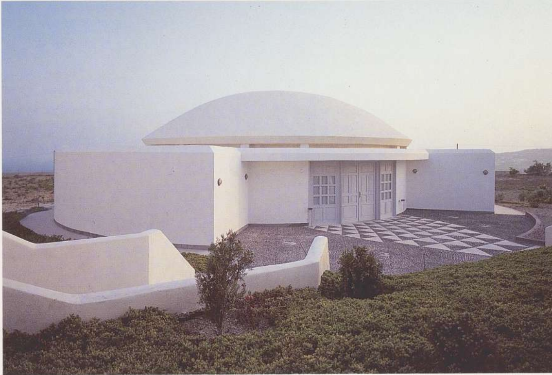
Fig. 84 La "Tholos" de l'installation vinicole Boutari. Ligne traditionnelle et matériaux contemporains.
