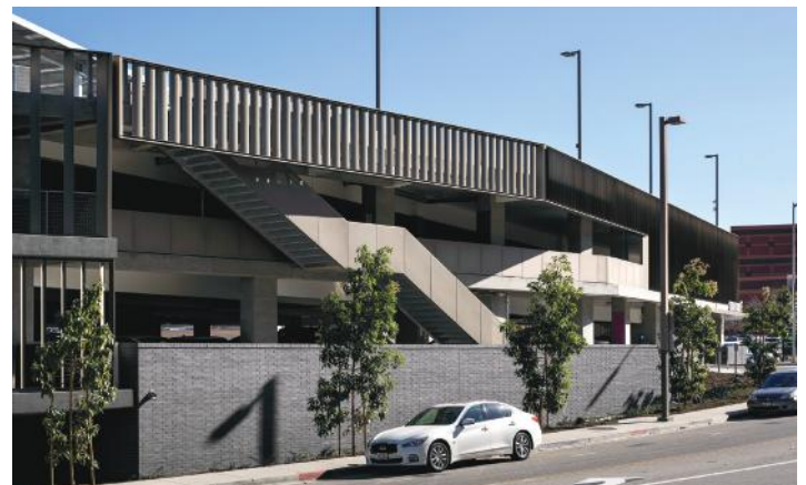
Universidad Estatal de California, Los Ángeles, Estructura de Estacionamiento E, Los Ángeles, CA, EE. UU.
