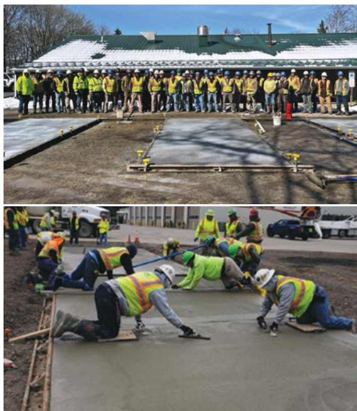
Fig. 6: Fotografía tomada en el Programa de Acabadores de Concreto de Pensilvania. A la fecha, más de 2,100 acabadores en Pensilvania han completado este programa.
