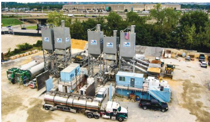
Fig. 5: Planta de concreto cercana a la obra de Miller and Long, LLC, que utiliza una mezcla de concreto con una combinación ternaria, con cemento Tipo IL y dos materiales cementantes suplementarios (SCM)
