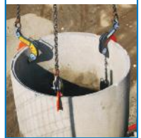
• Per pozzetti For concrete shafts
