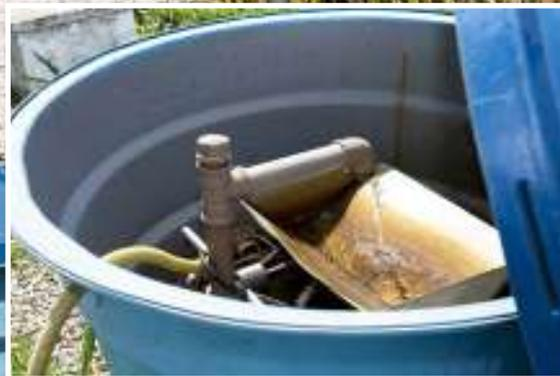
Acima, distribuição do esgoto a ser tratado na interface solo-planta; à esquerda, dispositivo de medição da quantidade de esgoto tratado pelo sistema.
