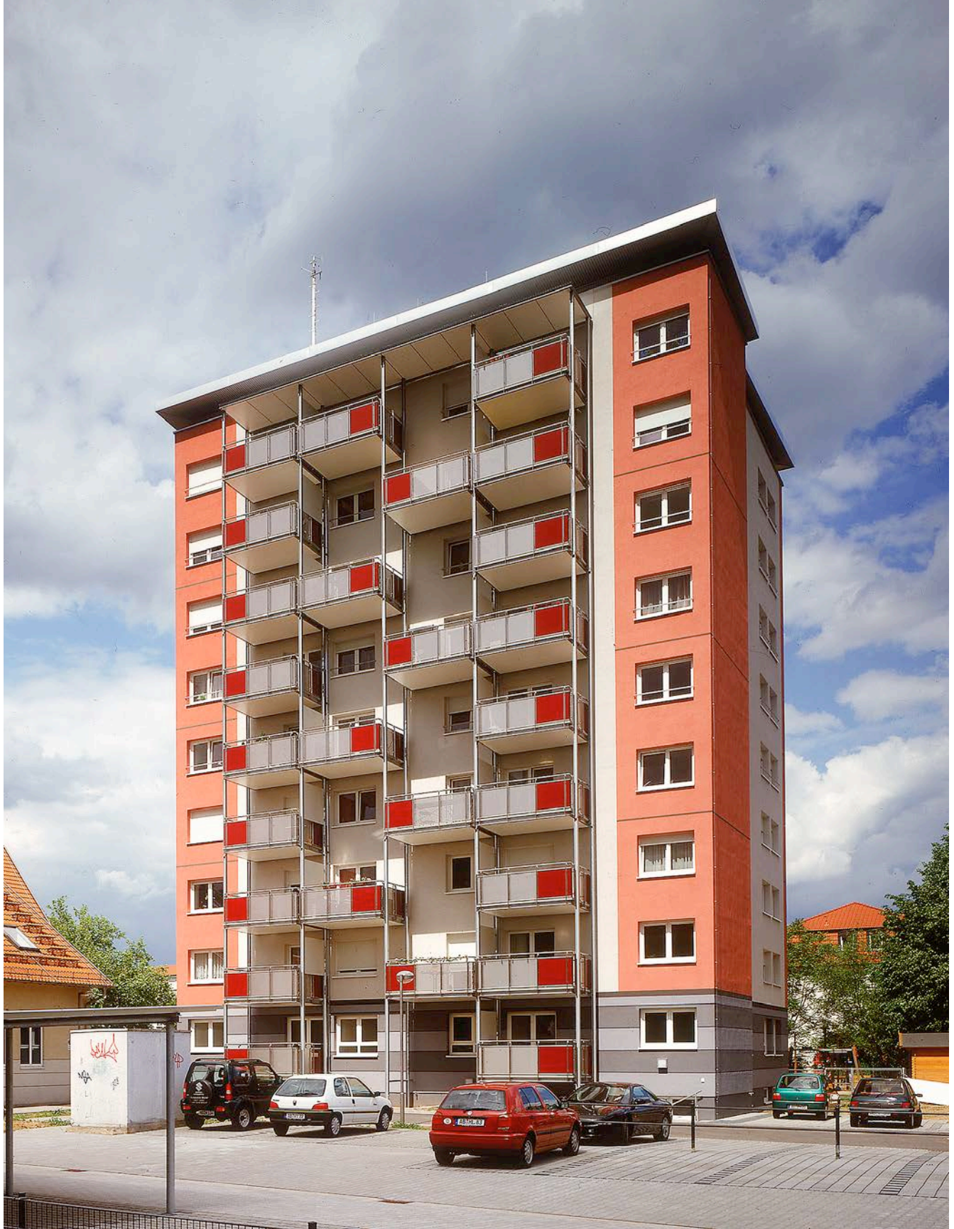
Die Lamprechtstraße 4 nach der Sanierung im Jahr 2007.
