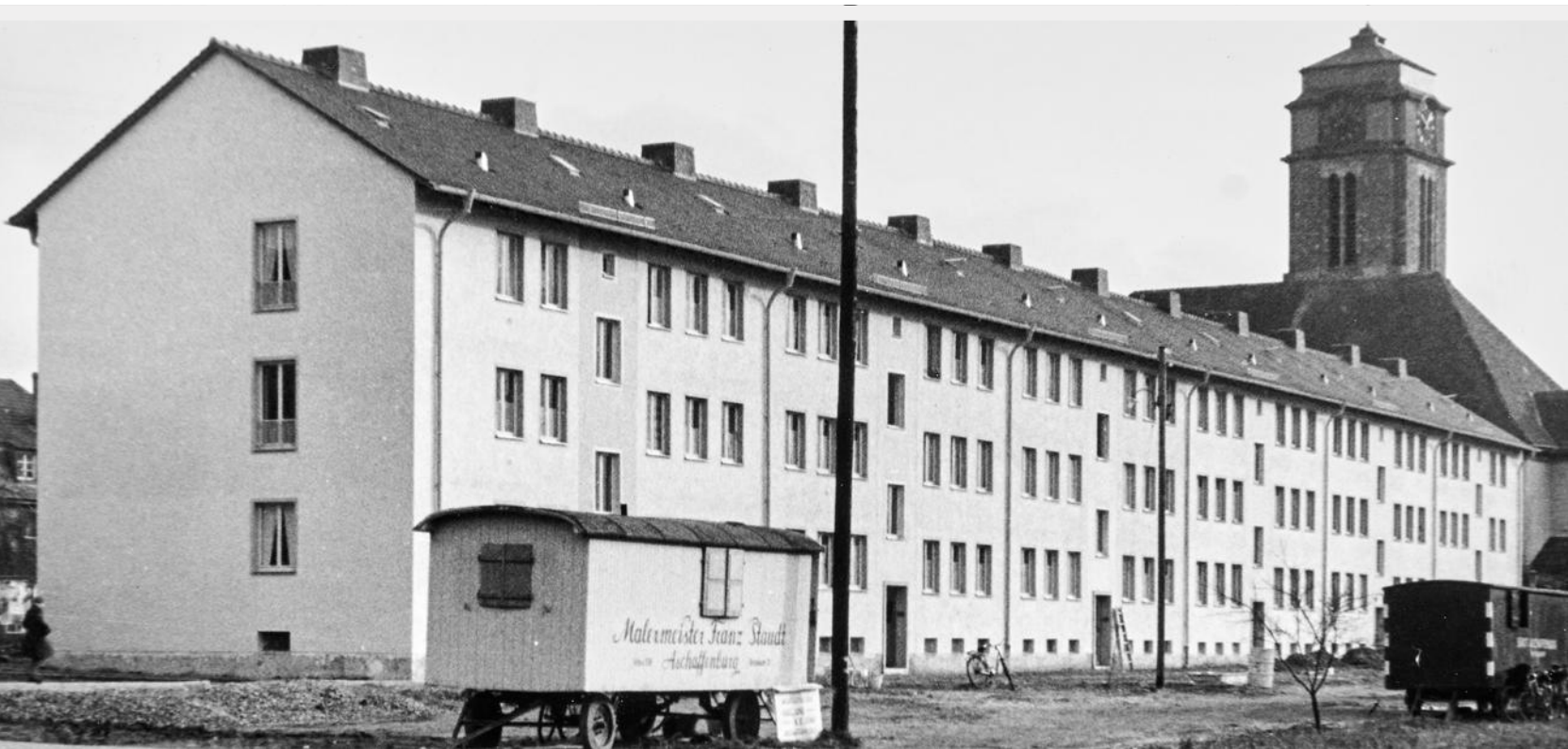
Unten: Die Häuserreihe Laurentiusstraße 1 bis 11 fluchtet auf den Haupteingang der St. Laurentiuskirche im Hintergrund. Die uniforme Fassadengestaltung ist auf Zweckmäßigkeit ausgelegt. Das Foto entstand während der abschließenden Bauarbeiten. Der Bauwagen des Malermeisters Franz Staudt ist im Vordergrund gut zu erkennen.
