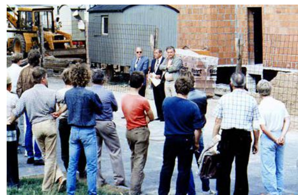
30. Juli 1985: Wieder kann am Hasenhägweg Richtfest gefeiert werden.
