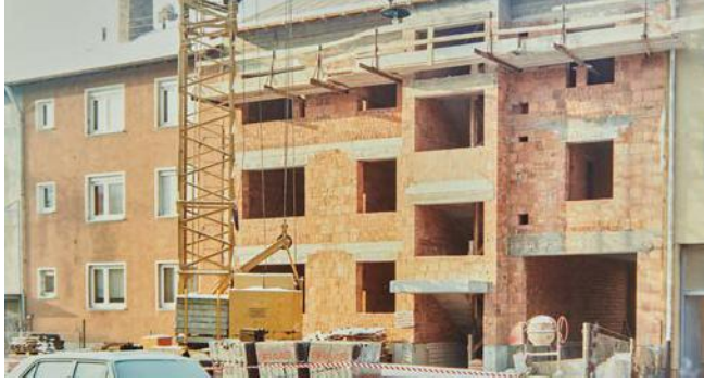
Rohbau der Boppstraße 7 im Winter 1981 / 1982.
