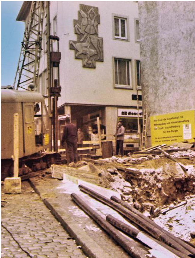
Ein Blick auf die Baugrube an der Dalberstraße 4 und 6 zu Jahresbeginn 1977.
