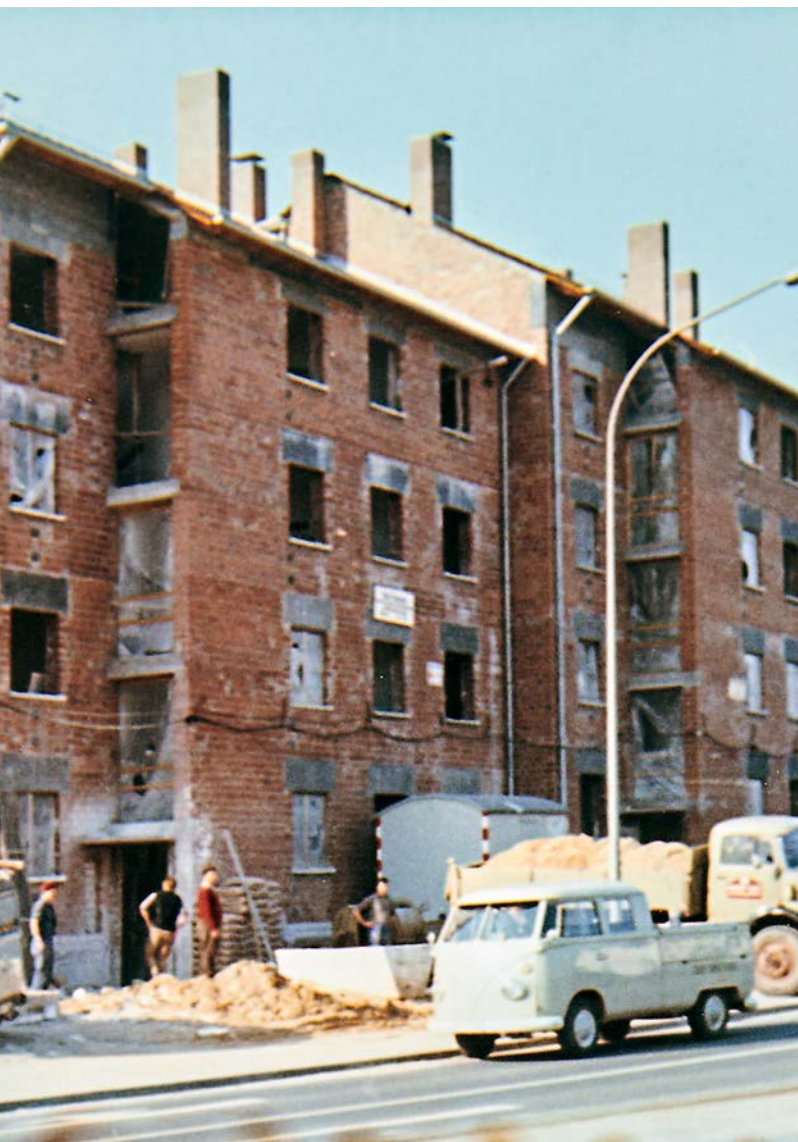
Von der Schillerstraße 1968 aus aufgenommen: Die im Rohbau fertiggestellten Häuser 59 und 61 bereits mit Dach und im Hintergrund ebenfalls die 63 und 65.
