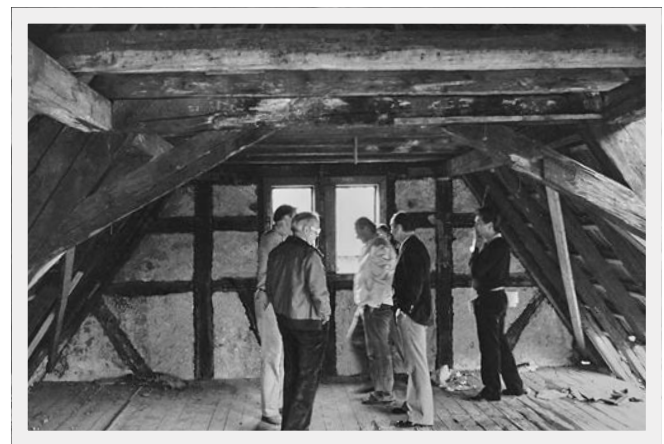
Ortsbegehung im Dachstuhl der Dalbergstraße 47.
