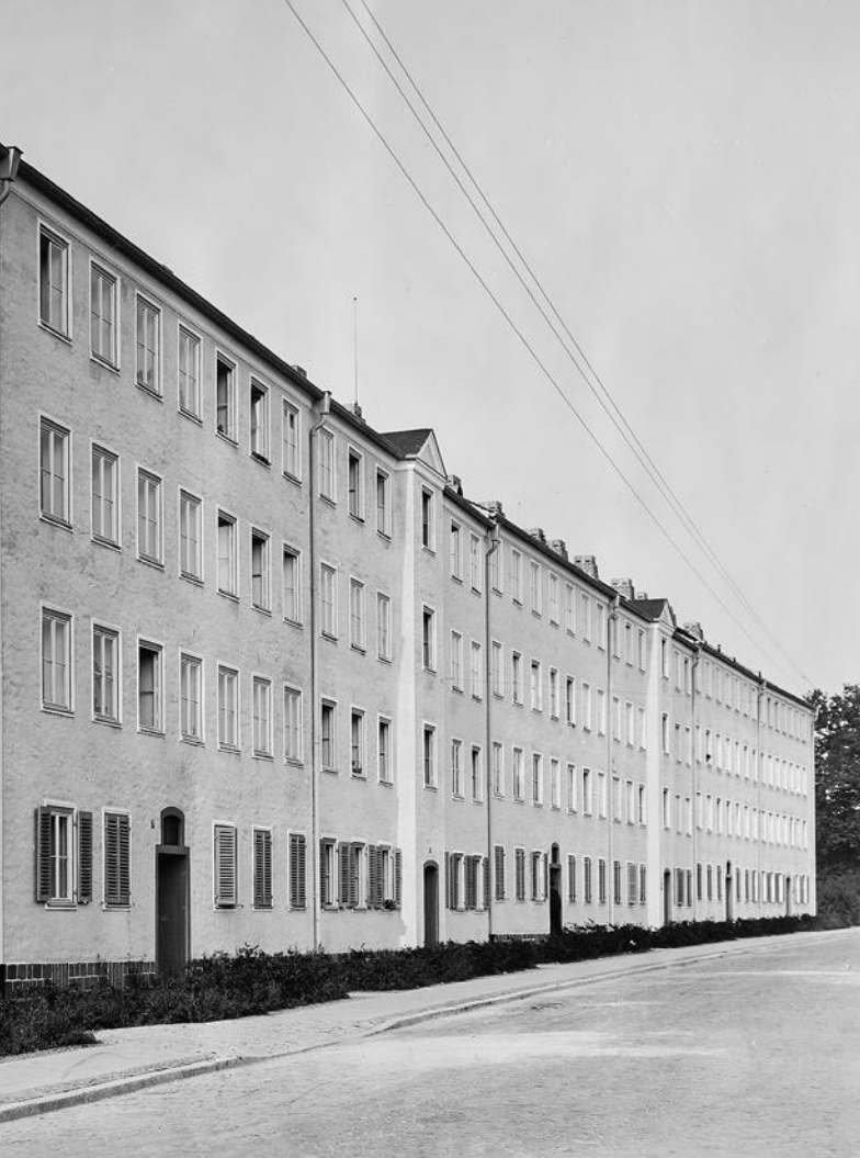
Links: Der an Neujahr 1951 fertiggestellte Block in der Breslauer Straße 31 bis 41.
