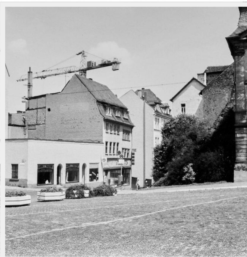
Die bauliche Situation vor Beginn der Maßnahme 1976. Das hinter dem Ruinen-Eckgrundstück befindliche Gebäude samt Café war denkmalgeschützt.
