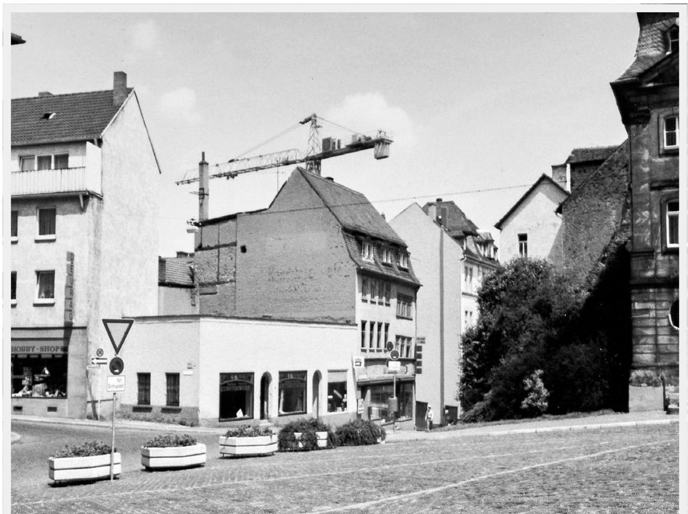
Zustand vor der Sanierung 1976.
