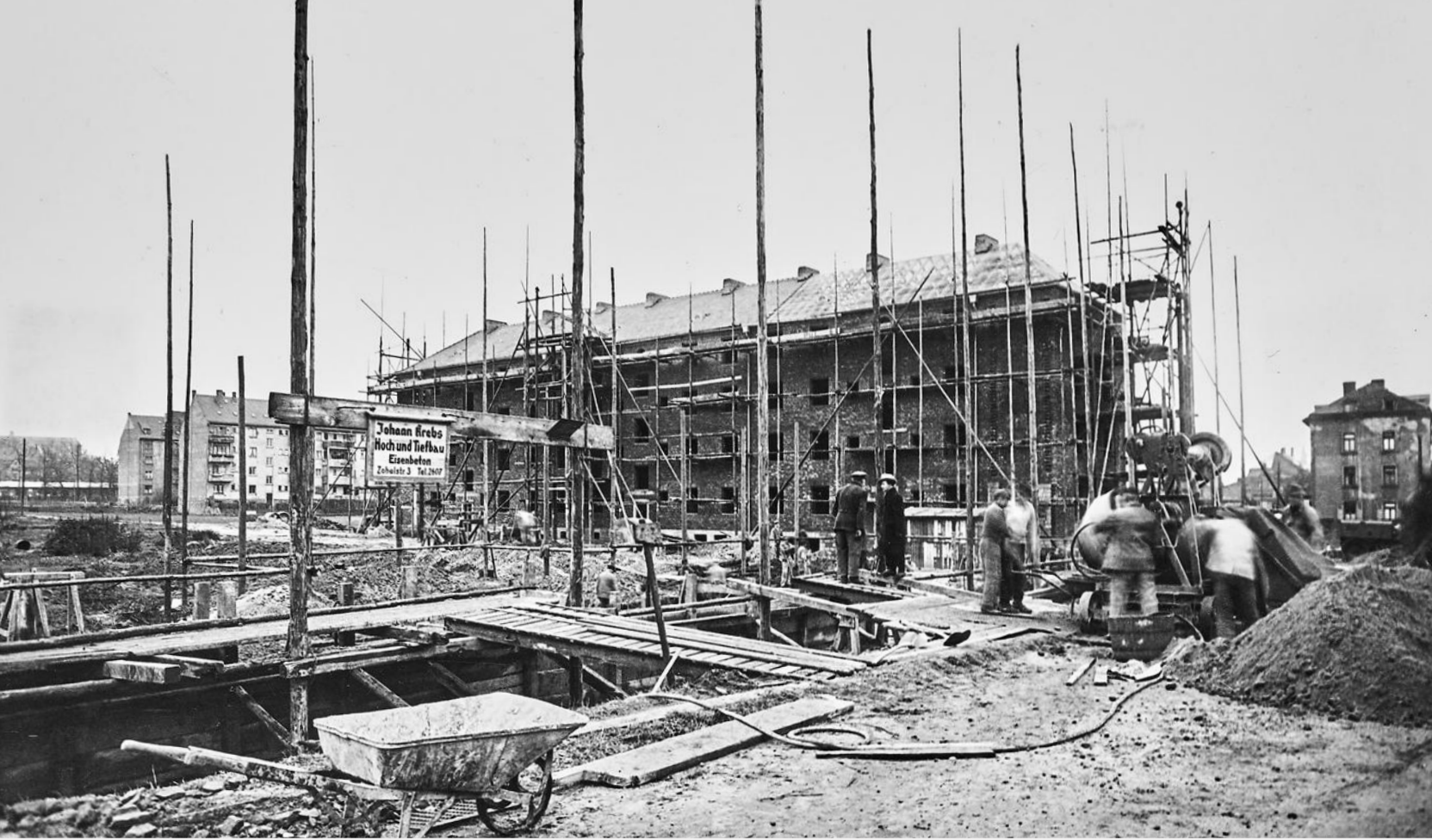
Erdaushub und Gründung für die Neubauten am Breslauer Platz für die Verlängerung Fabrikstraße. Hier entstehen 50 Wohnungen und zwei Läden. Das handgepinselte Schild weist „Johann Krebs – Hoch- und Tiefbau – Eisenbeton“ als ausführende Firma aus, die hier offenbar gerade das Fundament gießt. In der Aufsichtsratsitzung vom 28. Januar 1950 hatte man sich dafür entschieden, die Aufträge an diejenigen Anbieter zu vergeben, die anstelle einer Ulitzka-Decke eine Remy-Decke (beides Stahlbetondeckensysteme) kalkuliert hatten. Aufnahme 1950.
