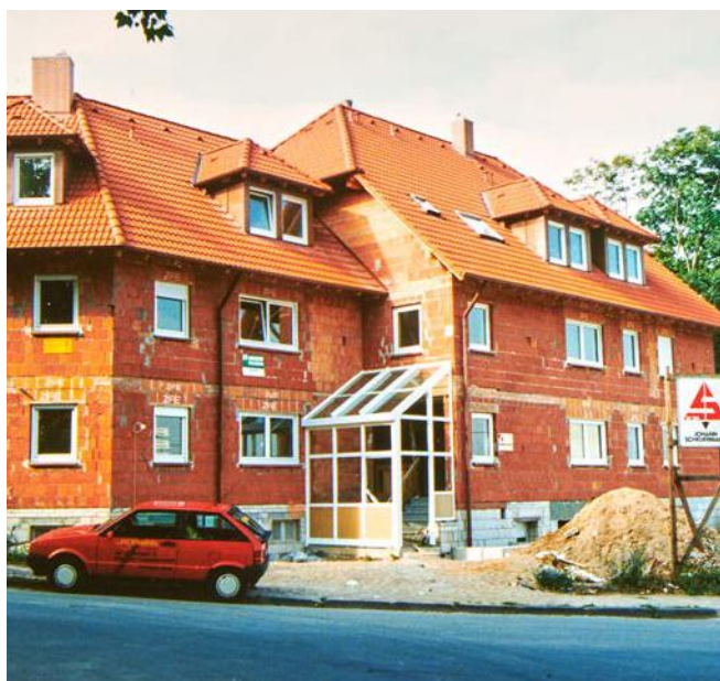
Straßenansicht der Hefner-Alteneck-Straße 71 und 73. Die Satteldachkonstruktion mit Walm und Gauben war recht aufwändig angelegt.
