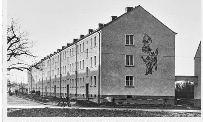
Wie bereits des Öfteren umgesetzt, schloss über Eck ein Torbogen die Verbindung zur Häuserreihe zwischen der Laurentiusstraße und den Gebäuden am Leiderer Stadtweg 61 bis 65.
