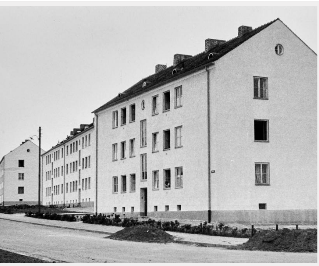
Die Häuser in der Lindestraße 16 bis 22 entsprachen dem Bautyp der etwas nördlich gelegenen Häuser in der Siemensstraße. Zusätzlich zu der sukzessiven, schnellen Bebauung des Hefner-Alteneck-Viertels konnten für das bundesweite „Wohnungsbauprogramm für Altbesatzungsverdrängte“, das ab 1951 in Kraft trat, auf den zuvor stückweise angekauften Grundflächen in Damm an der Schillerstraße und am Schneidmühlweg fünf Häuser mit einer Kapazität von 33 Wohnungen errichtet werden.
