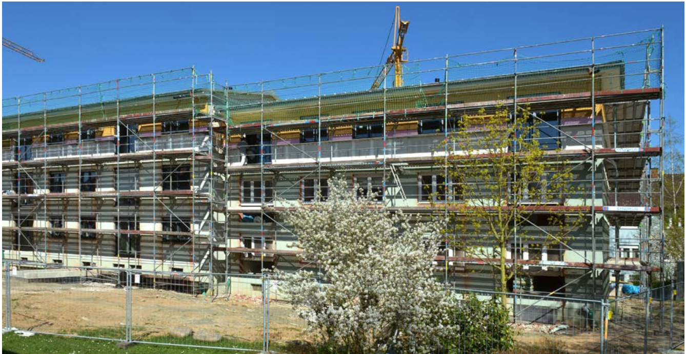
Bauarbeiten für die Aufstockungen am Finkenweg.
