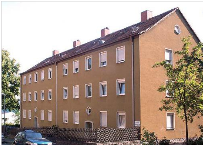
Die Koloseusstraße 1 und 3 vor der Sanierung....
