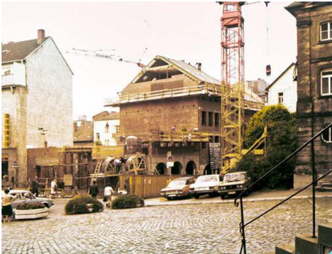
Die Bauarbeiten an der Dalbergstraße 4 und 6 sind bis zu den Arkaden fortgeschritten.
