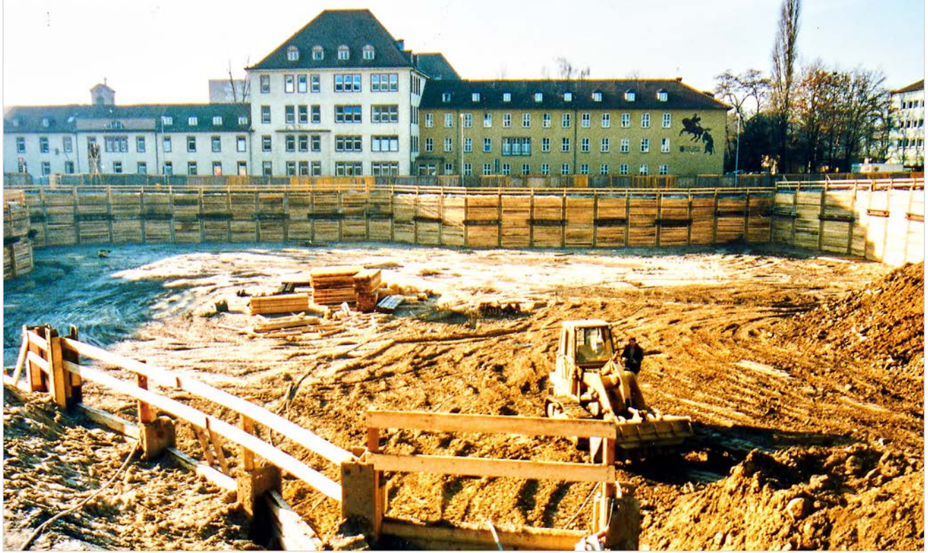
Einen Monat später konnte bereits bei Erreichen der Sole mit dem sogenannten „Berliner Verbau“ begonnen werden.
