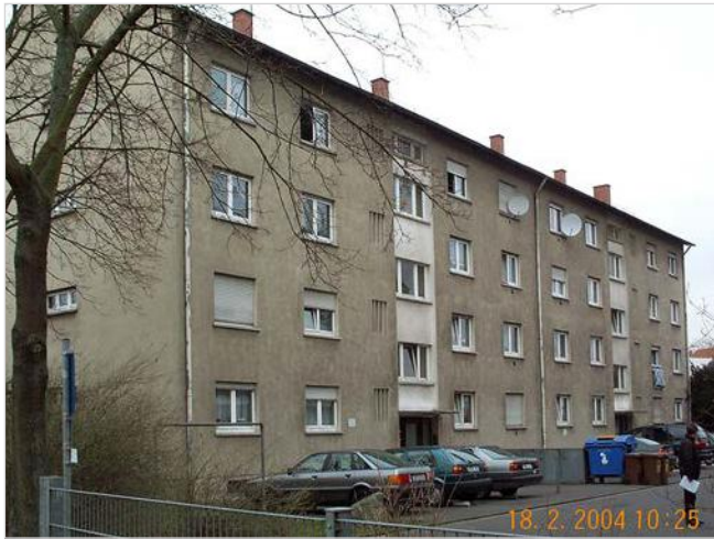
Die Schillerstraße 91 und 93 vor der Sanierung...
