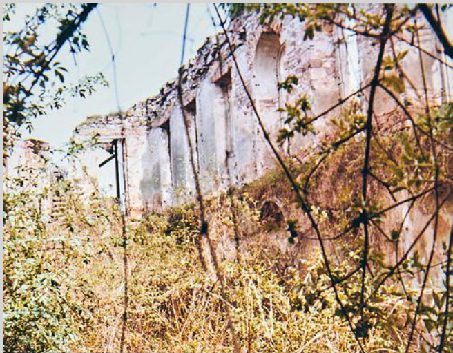
Innenansicht des Gebäudes vor Beginn der Bauarbeiten.
