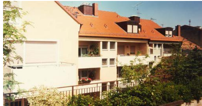
Die Rückansicht der Gebäude an der Landingstraße 9, 11 und 13 zum Hang an der Landingstraße hin, an dem ein Terrassengarten angelegt wurde.
