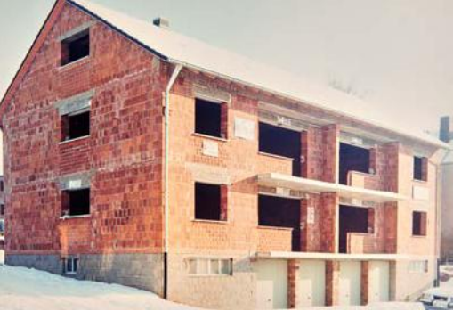
Die Freundstraße 6 und 6 a im Rohbau.
