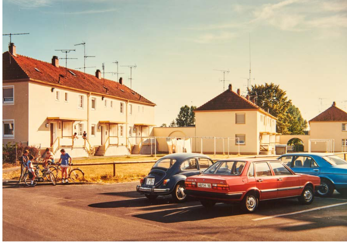
Die Gebäude am Starenweg Ecke Adlerstraße in einer Aufnahme aus den 1980er Jahren.
