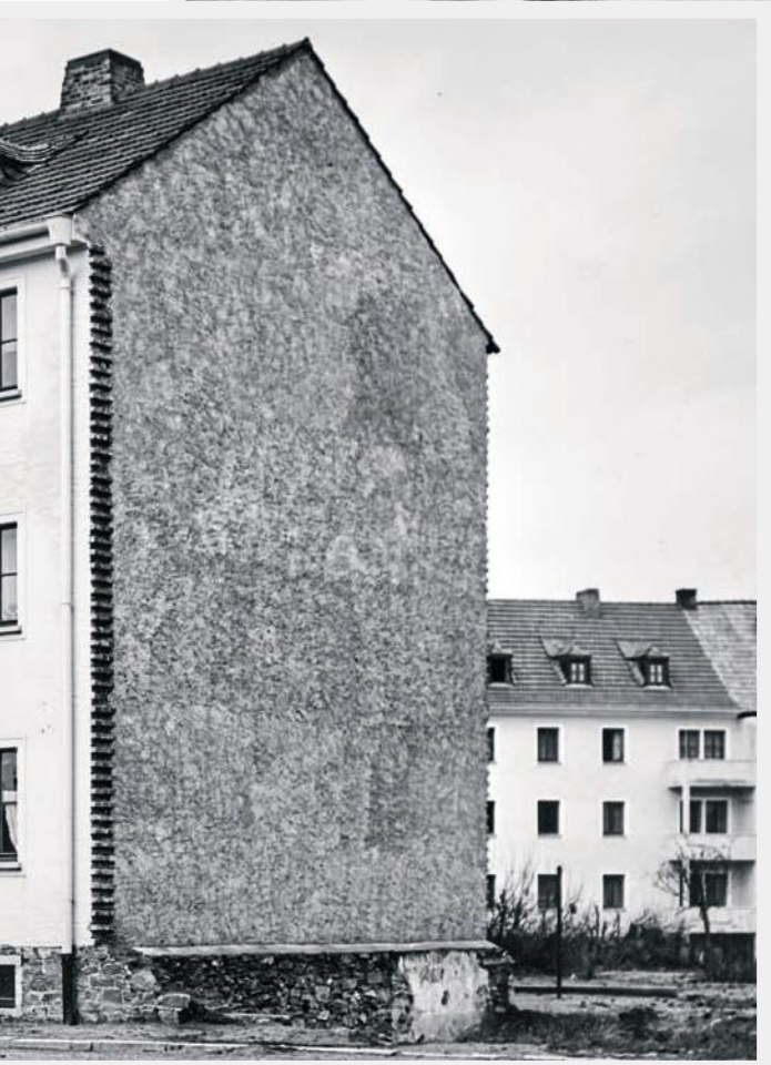
Links: Die eben fertiggestellte Uhlandstraße 14 von der Straßenseite aus. Der Schnitt wurde an die vorhandene Bausubstanz angepasst. An der rechten Seite (unverputzt) konnte die Wohnungsbaugesellschaft wenig später eine weitere Baumaßnahme anschließen.
