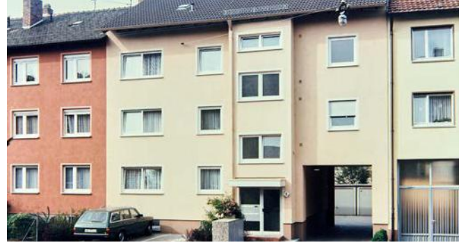
Die Boppstraße 7 ist ein gelungener „Lückenschluss“.
