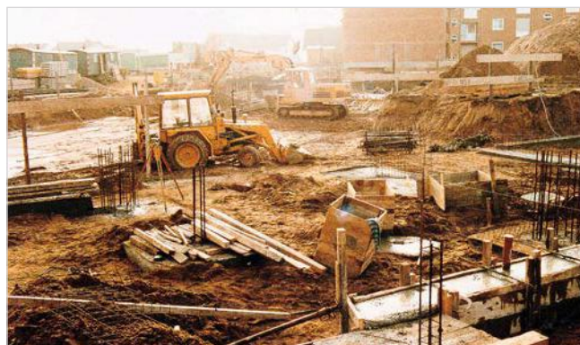
Gründungsarbeiten für den zweiten Bauabschnitt am Hasenhägweg.
