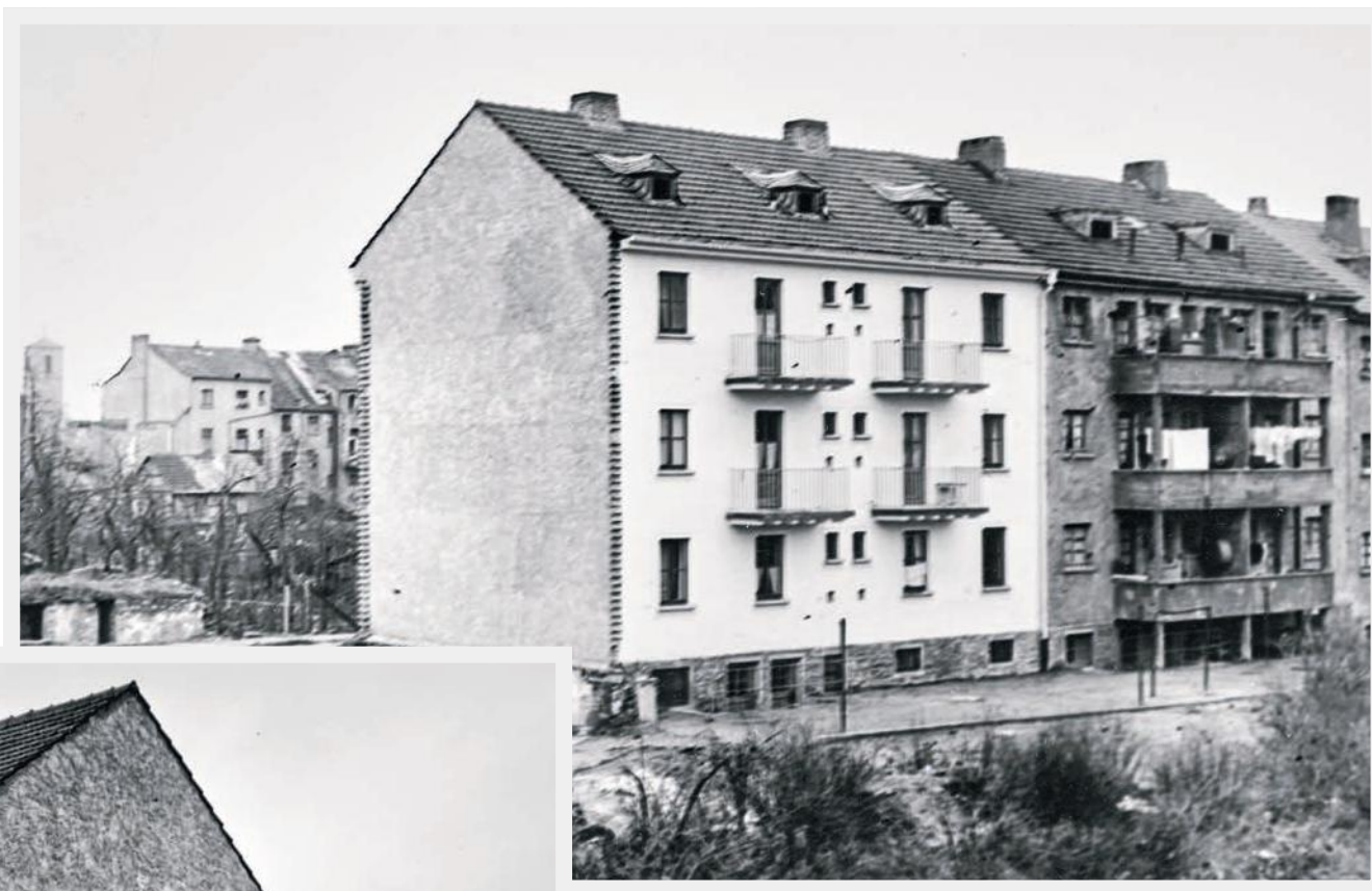
Oben: Rückseite der Uhlandstraße 14 mit Balkonen.
