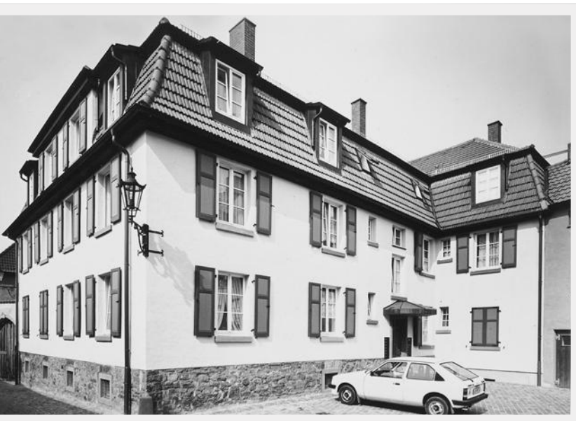
Stiftsgasse 10 a Zustand nach der Sanierung 1988.
