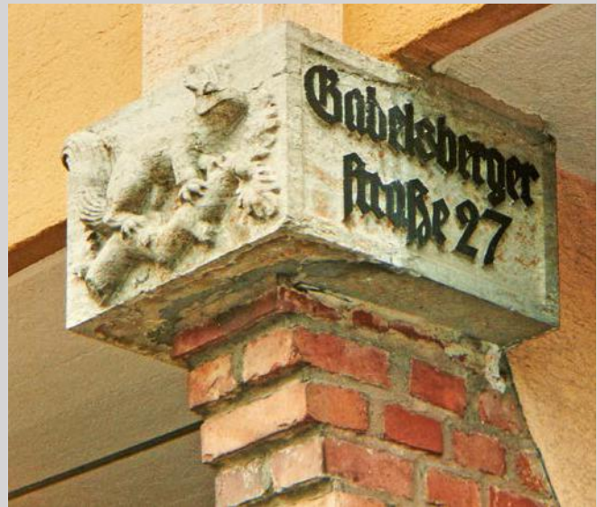
Detail am Gebäude des „Gabelsberger Blocks“ aus der Bauzeit (1920er Jahre). Kragstein mit Hausnummer (Foto 1990).
