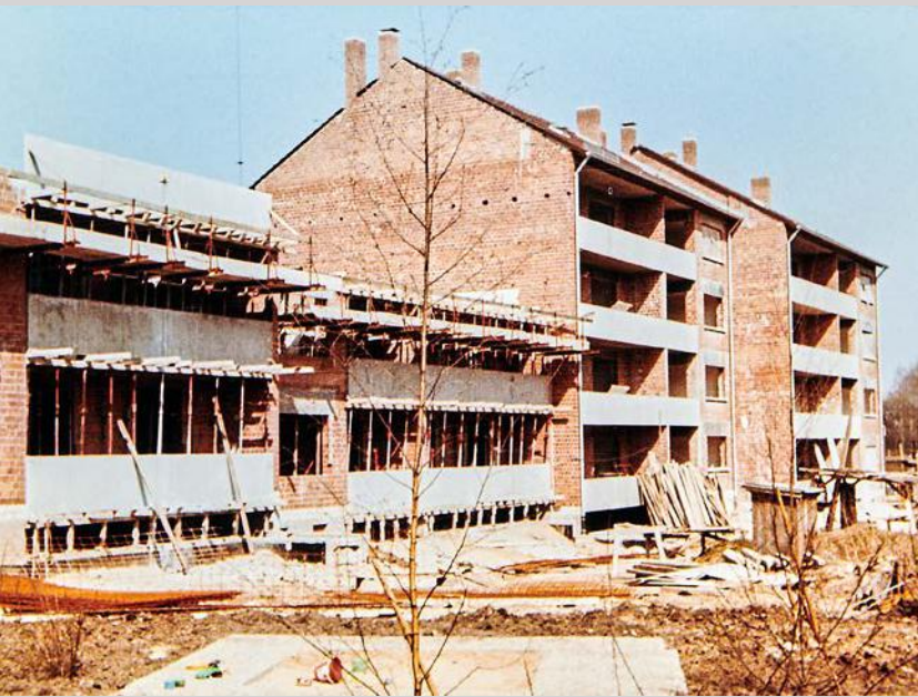
Links: Die Hofseite der Schillerstraße während der Bauphase im Sommer 1968.
