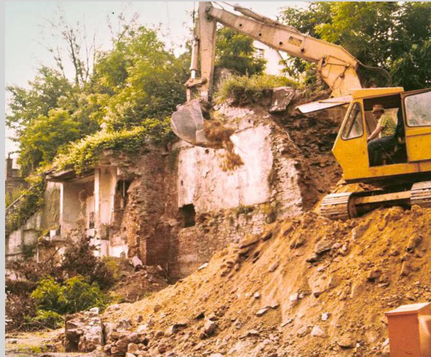
Beginn der Hangsicherung an der Landingstraße.
