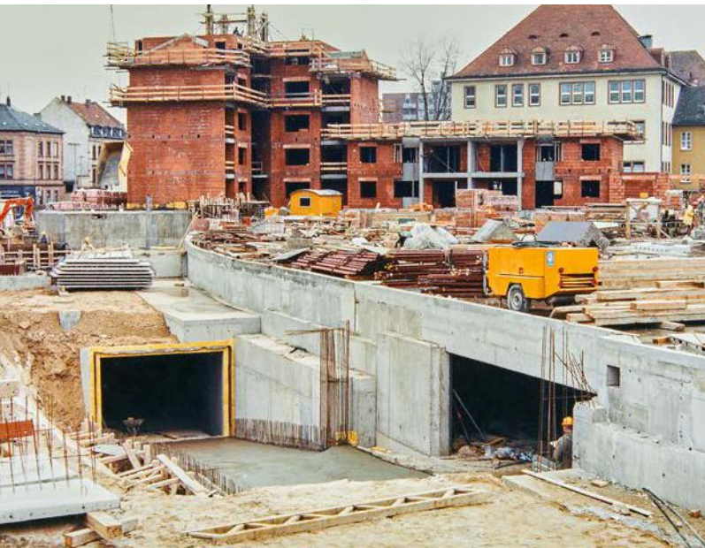
Im März 1988 begannen die Maurerarbeiten an der Ecke Werbachstraße / Alexandrastraße, während zeitgleich der Ausbau der Tiefgaragen vorstättenging.
