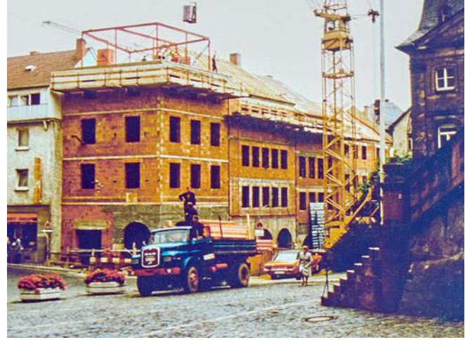
Rohbau der neuen Arkadengebäude an der Dalbergstraße 4 und 6.
