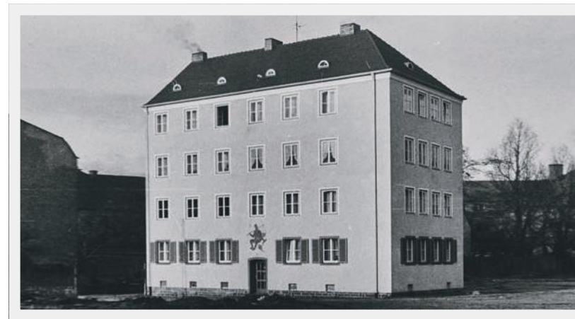
Das bald nach Fertigstellung veräußerte Anwesen Goethestraße 35.
