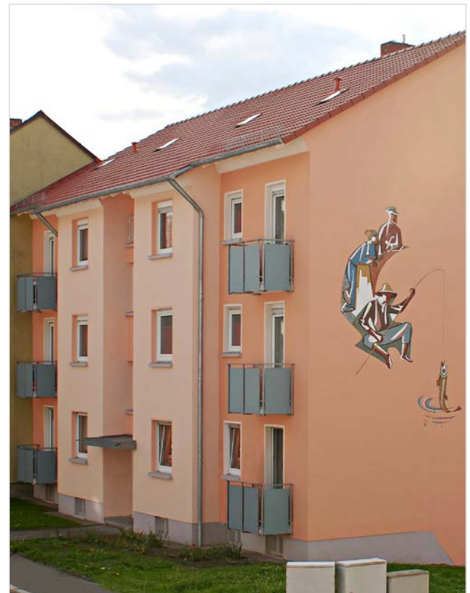
Unten: Die sanierte Fischergasse 22 im Jahr 2007, bei der besonders auf den Erhalt des Fassadenschmucks von 1958 geachtet wurde.
