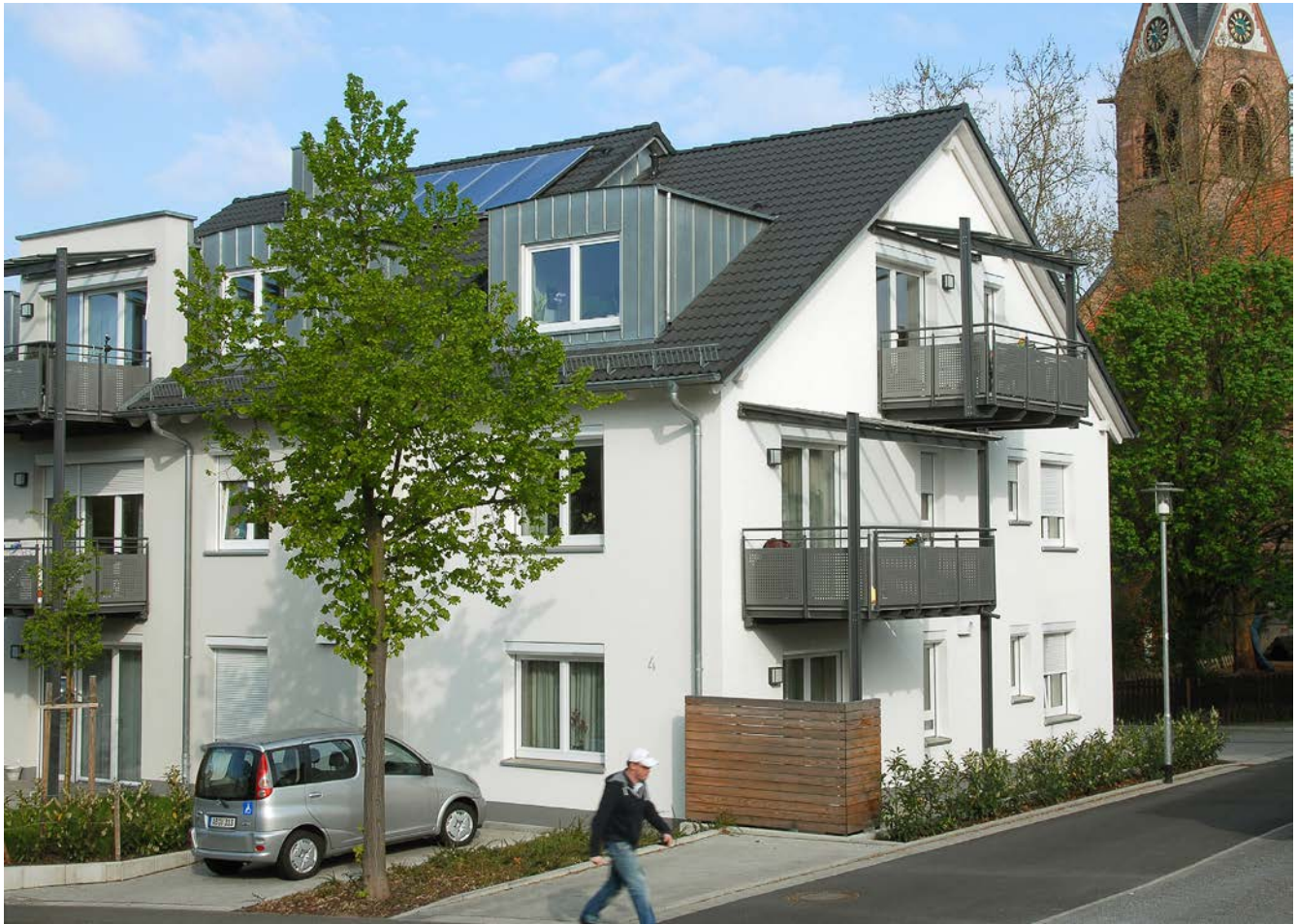
Das fertiggestellte KfW Effizienzhaus 40 in der Hensbachstraße 4 in Schweinheim.
