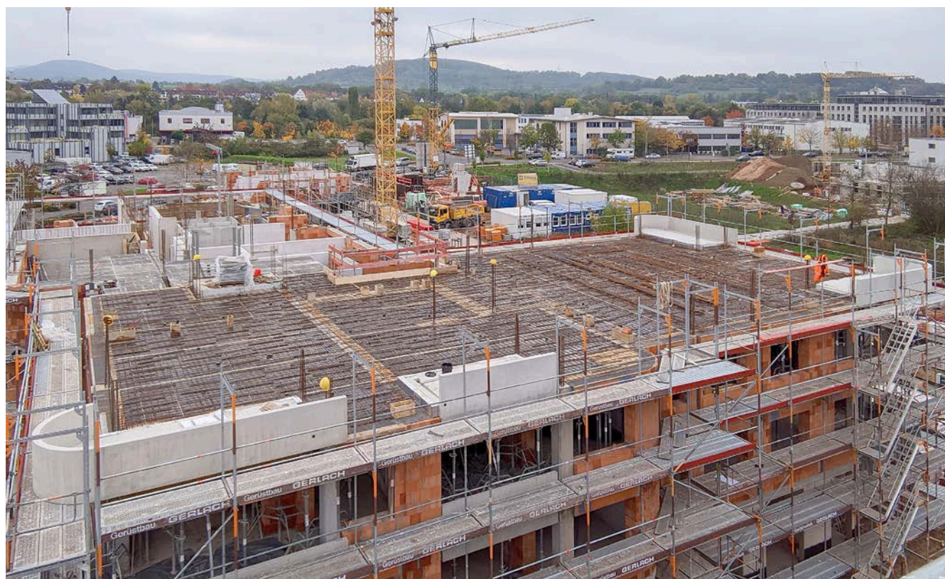
Rohbau der Schopenhauerstraße 1 bis 11 im Oktober 2022. Seit dem Spatenstich war noch kein Jahr vergangen und die Arbeiten blieben im Zeitplan.
