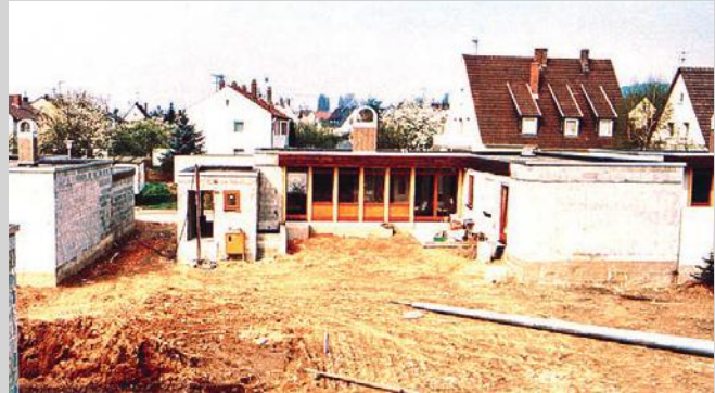
Rohbau der Kaufeigenheime am Falken-, Meisenweg und der Habichtstraße 1980.
