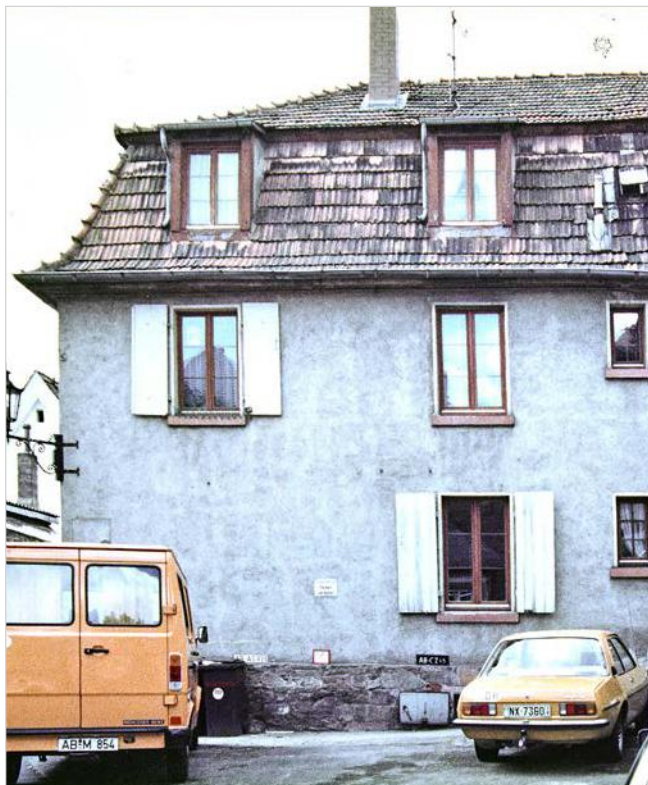
Außenansicht der Stiftsgasse 10 a vor Beginn der Maßnahmen.
