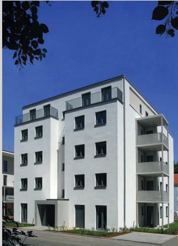
Das Null-Emissionshaus (KfW-Effizienzhaus 55) am Schneidmühlweg 58 bis 60 kurz vor dem Bezug.
