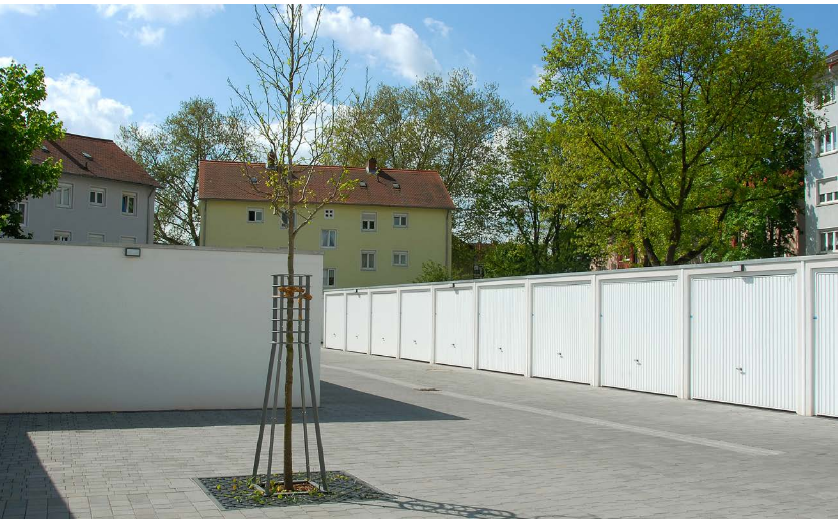
Unten: Der 2009 neu eingerichtete Garagenhof in der Bernhardstraße.
