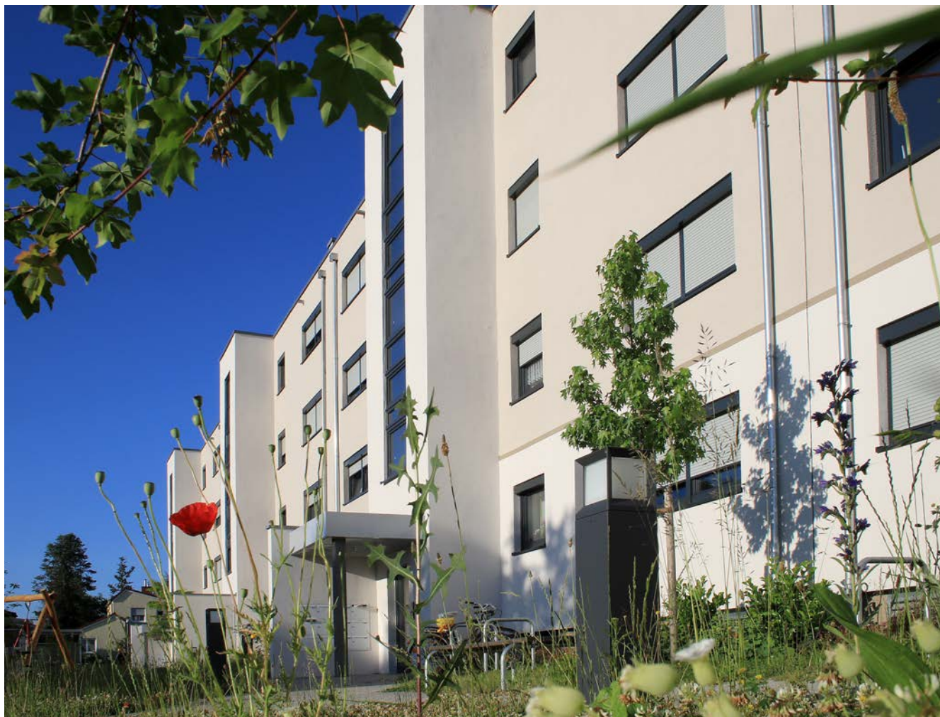
Unten: Die sanierten Gebäude am Ginsterweg 2 bis 8. Das Wohnumfeld wurde mit Blühwiesen optimiert.
