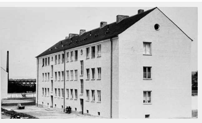
Siemensweg 5 und 7 bei der Fertigstellung der Außenanlagen.
