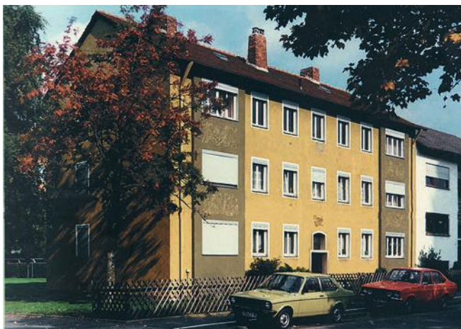
Der Friedrich-Krane-Platz 8 vor der Sanierung...
