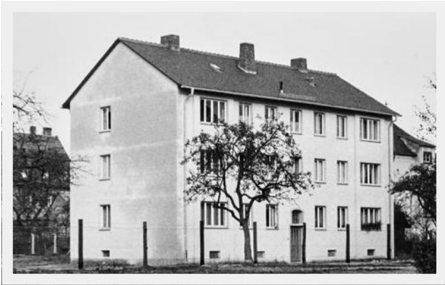
Links: Das fertiggestellte Wohngebäude am Friedrich-Krane-Platz 8 in Leider. Die Fenstergestaltung und die Konzeption lässt unmittelbar erkennen, dass sie von anderer Hand stammt als dem Baureferat der Stadt. Der drei Meter breite Vorgarten ist plangerecht wiederhergestellt und mit einem Zaun versehen.
