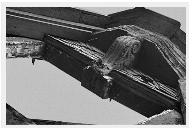
Zu sichernde Fachwerkelemente des Giebels vor dem Rückbau der Dalbergstraße 45.
