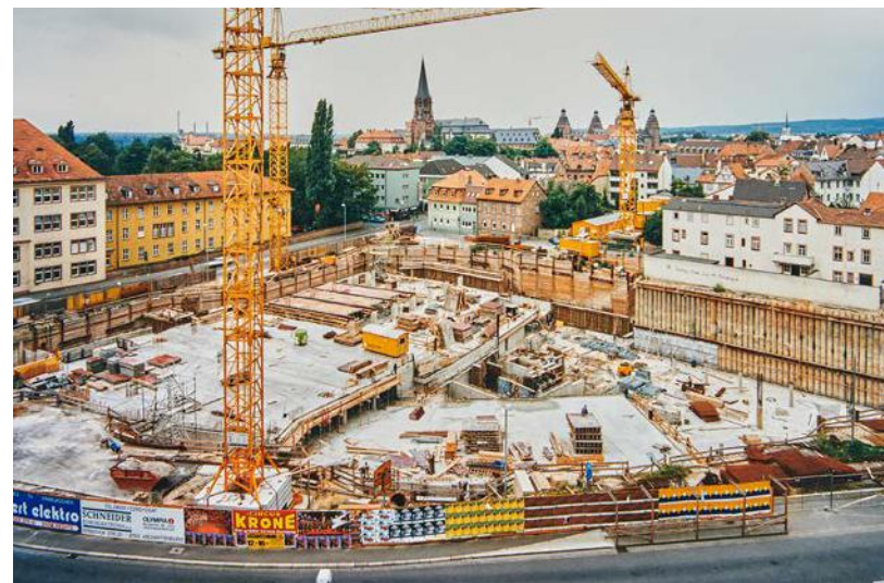
Unten rechts: Ende September war die obere Decke der dreigeschossigen Tiefgarage fertiggestellt.
