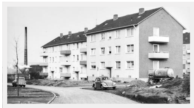
Oben: Die östlich gelegene parallel angelegte Häuserreihe Spessartstraße 63 bis 67 kurz nach der Fertigstellung im Frühjahr 1959. Beide Bauprojekte konnten über das staatliche Zins- und Tilgungsbeihilfeprogramm finanziert werden.
