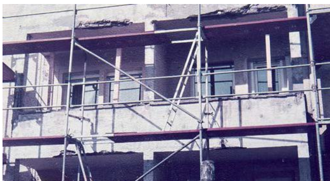
Betonsanierung in der Schillerstraße (April 1984).
