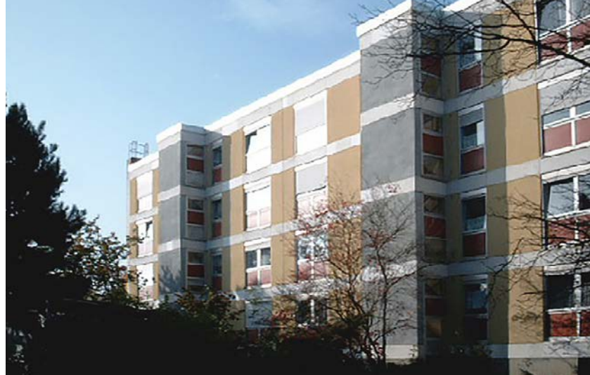
Oben: Ginsterweg 2 bis 8 vor der Sanierung.
