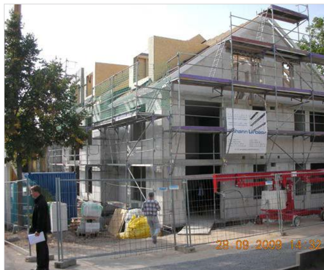
Oben: Richtfest in der Hensbachstraße 4 in Schweinheim.
