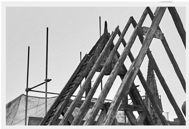
Der teilweise zurückgebaute Dachstuhl der Dalbergstraße 45.
