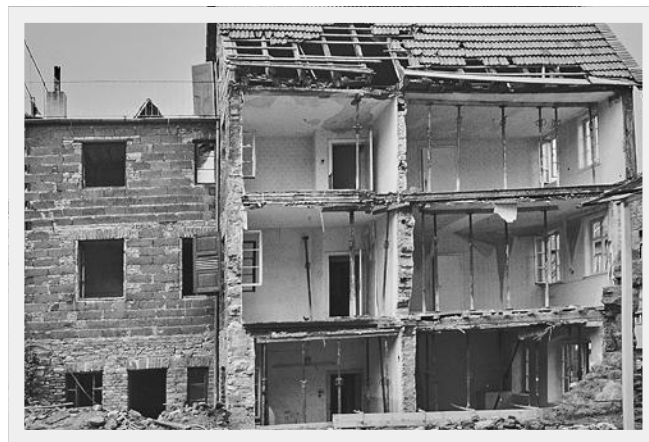
Die Dalbergstraße 47 nach dem vollständigen Rückbau der angrenzenden Dalbergstraße 45.
