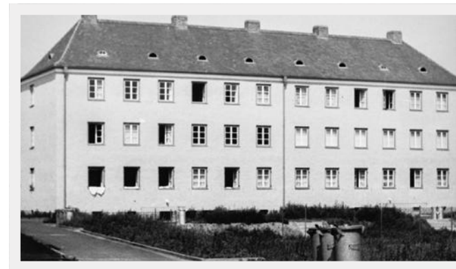
Die rückwärtige, sehr schlichte Fensterseite (Richtung Süden) der Häuser 31 und 29 .
