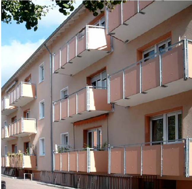
Hier wurden bei der Sanierung im Jahr 2000 erstmalig moderne Energiespartechnologien angewandt.
