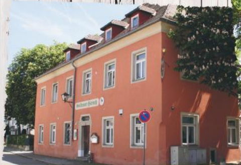
» Goldener Hirsch in Großprüfening
