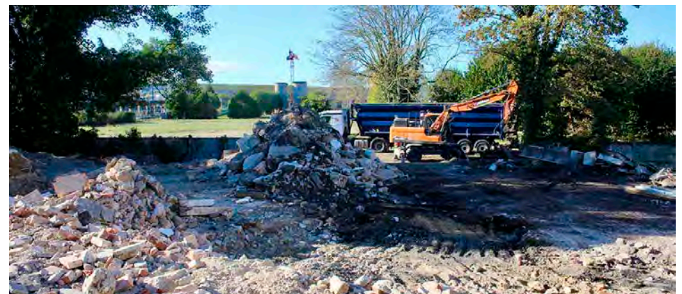
En face du numéro 42 de la rue de Reims, il ne reste que des gravats. © l'Hebdo du Vendredi
