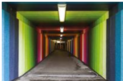
Place Chauderon Passage sous-voie sud-est
