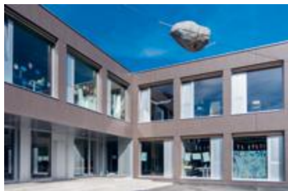
Collège de Chandieu Ch. de Chandieu 23 Préau
