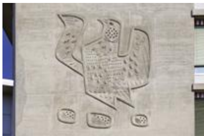
Collège du Belvédère Chemin des Croix-Rouges 24 Façade sud
