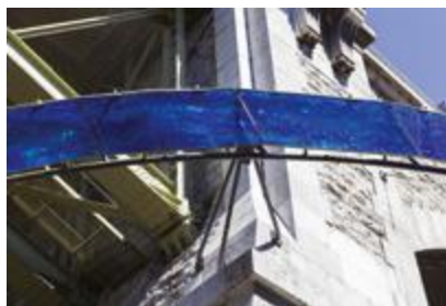
Station M2 Bessières Niveau Rue Centrale
