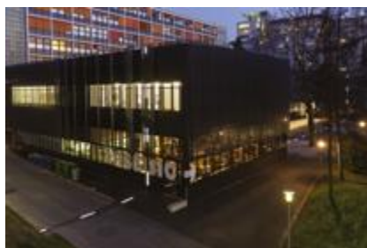
Arsenic Rue de Genève 57 Pourtour du bâtiment
