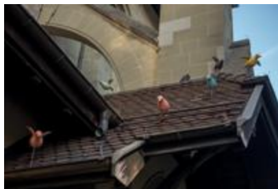
Église Saint-François Place Saint-François 18 Avant-toits du bâtiment
