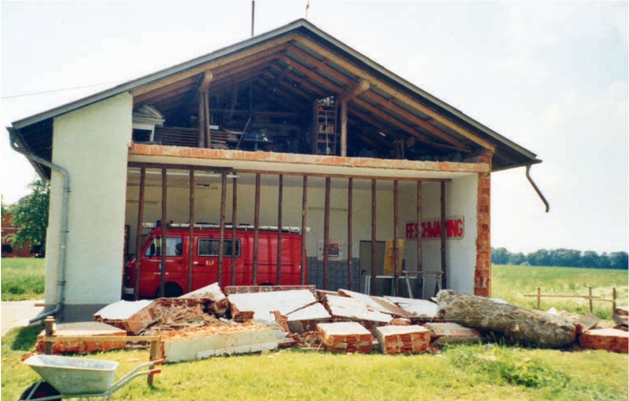
Feuerwehrhaus während dem Umbau
