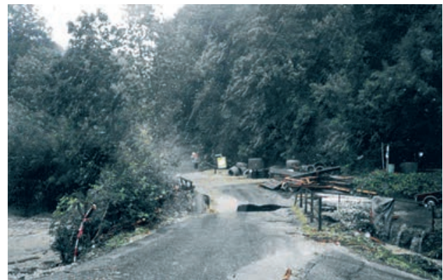
Am 12. August weggerissene Brücke in Rosenegg
