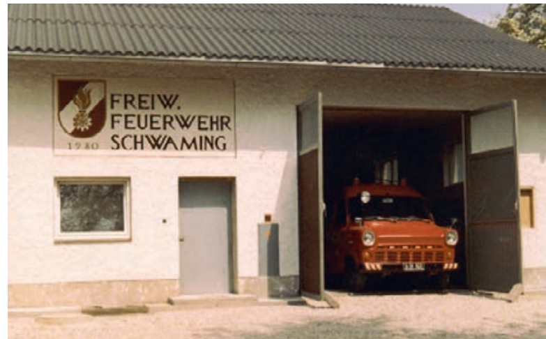
Feuerwehrhaus nach der Fertigstellung
