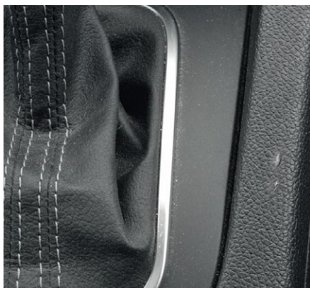
Endommagement léger du revêtement en plastique
