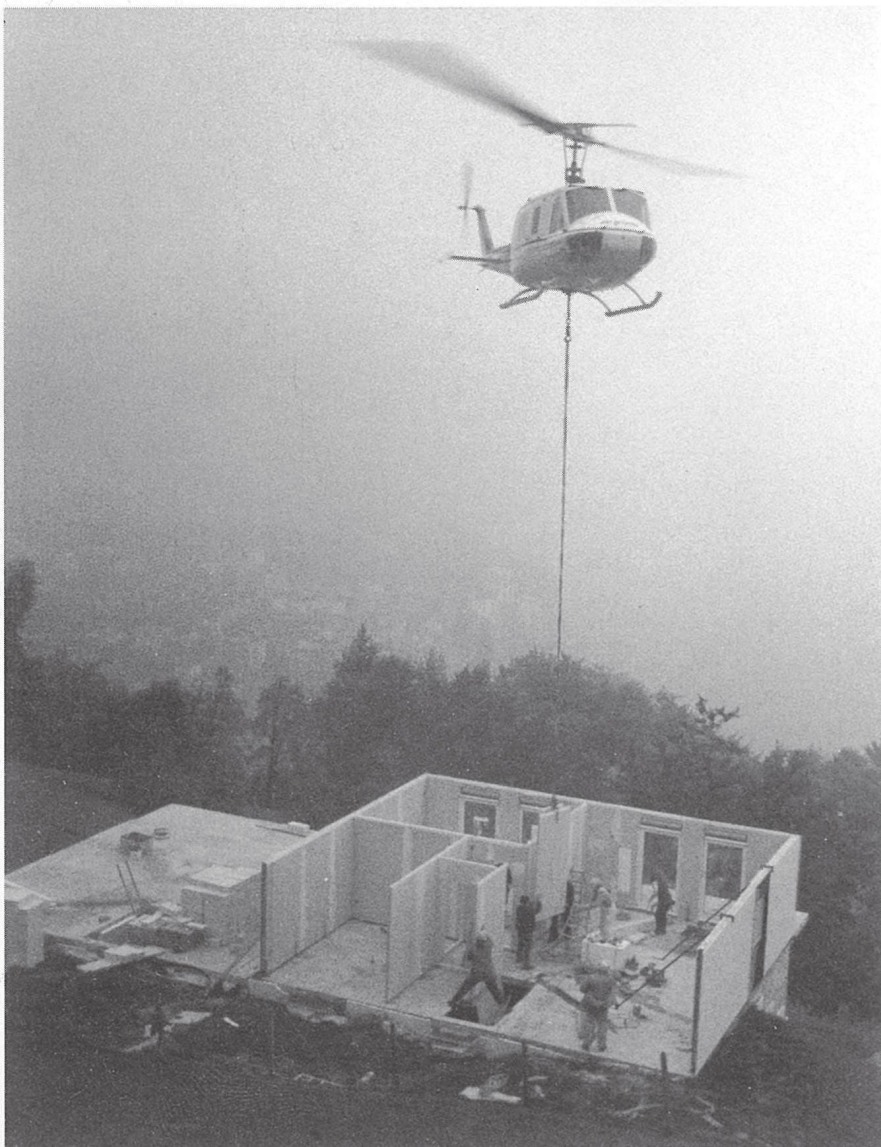
Wie man sieht, ist bei Fertighäusern fast alles möglich: Dieses Haus wurde in Rigi-Schwanden oberhalb Vitznau aufgebaut. Die Baustelle war nur durch einen Fussweg erreichbar, deshalb musste ein Helikopter eingesetzt werden.
