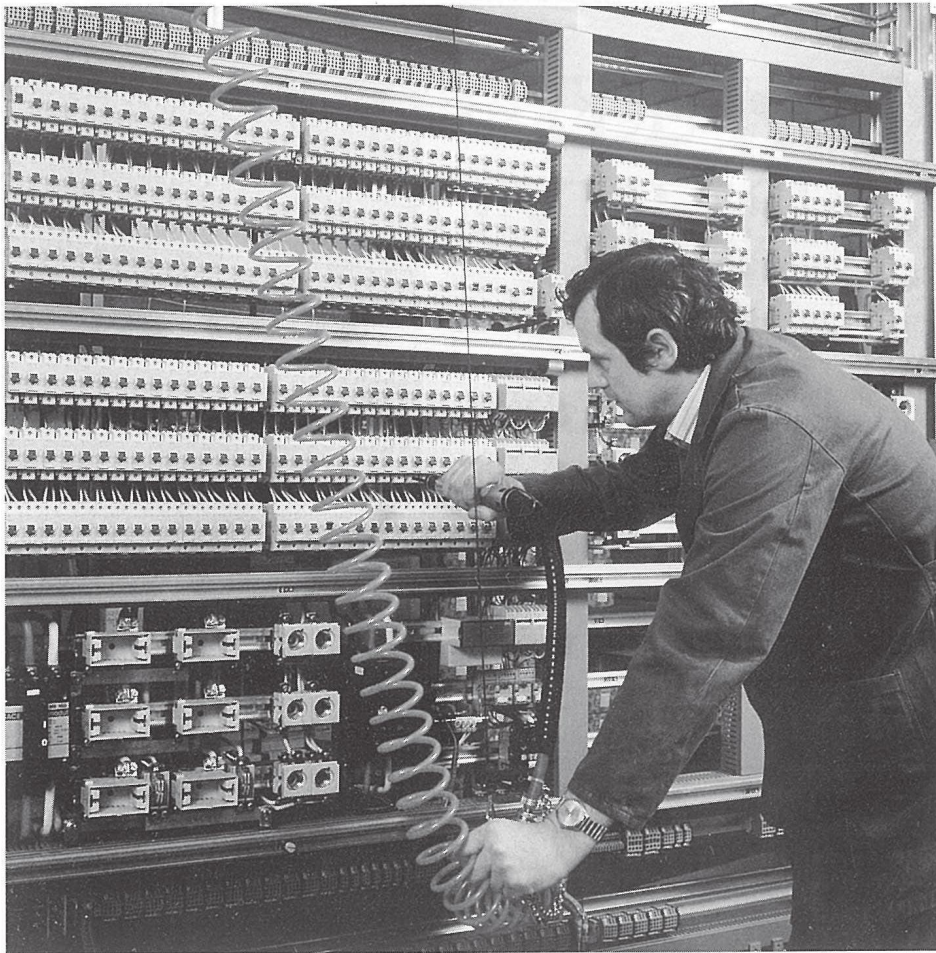
Sicherungsverteilung Industriebau, ausgeführt durch Jerzy Raszewski.
