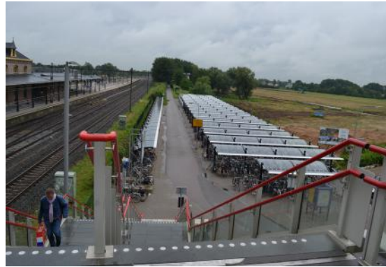
Station Geldermalsen: geen prettige ontvangst voor de reiziger door ontbreken ruim ontvangstdomein.
