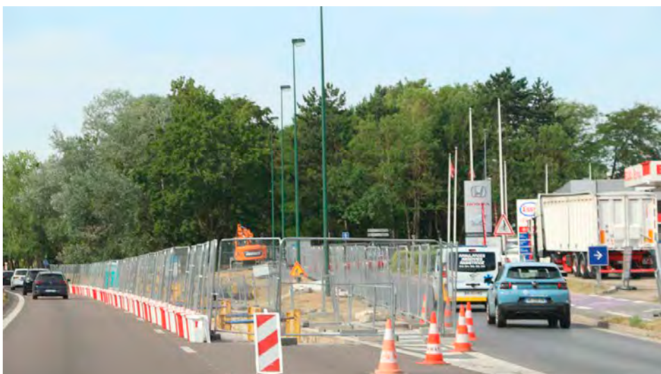
Les travaux du réseau de chaleur débordent jusqu'à l'avenue de Champagne. © l'Hebdo du Vendredi
