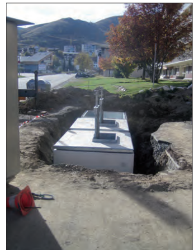
Een lokale aannemer kan de containers plaatsen.
