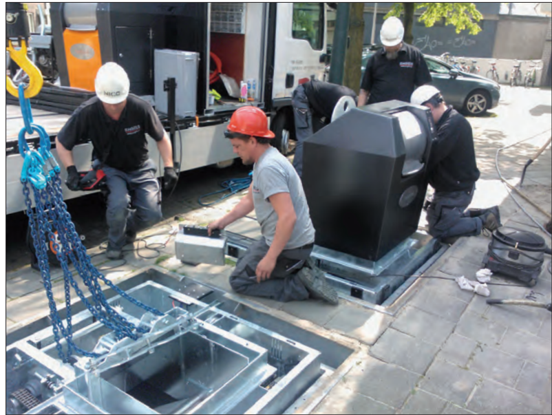
Plaatsing in bestaande betonputten en aanleggen van elektrische voeding.
