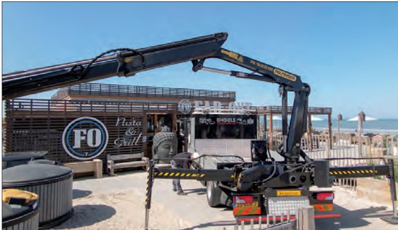
Onderhoudswerkzaamheden in Zandvoort.
