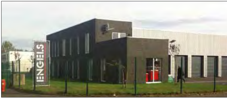
Engels Manutention et Environnement SARL, 1 Rue du Catillon, Leers, FR
