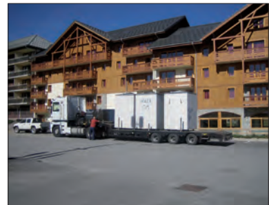
Aanvoer afgemonteerde putten en containers met veiligheidsvoorziening.
