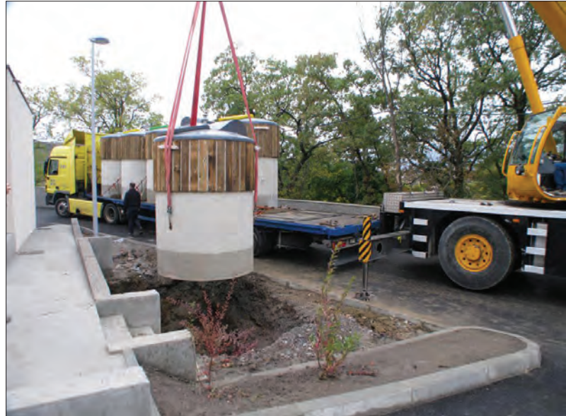
Plaatsing van Tierso's in Gap (Frankrijk) na het dichtgooien van de bouwput is het systeem klaar voor gebruik.
