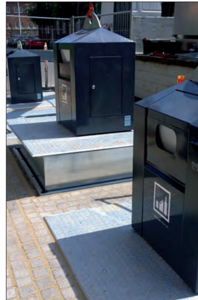
Project Horsens 2015 (Denemarken), oplevering van 300 Classic ondergrondse containers.
