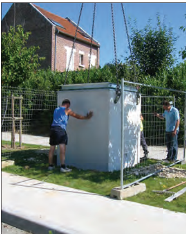
De betonput wordt in de voorbereide bouwput geplaatst.
