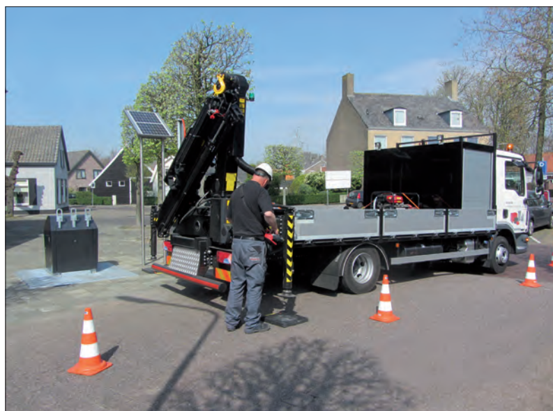
Locatie veilig gesteld. Werkzaamheden kunnen beginnen!
