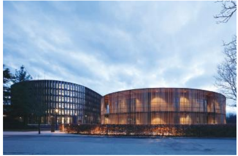
Ingenhoven associates, Hôtel de Ville, Fribourg-en-Brisgau
