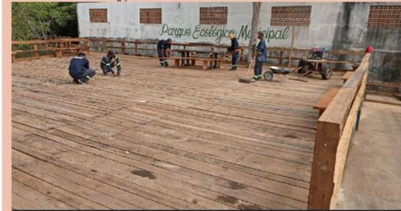
Mirante e parte da passarela foram concluídos pela equipe de Obras
