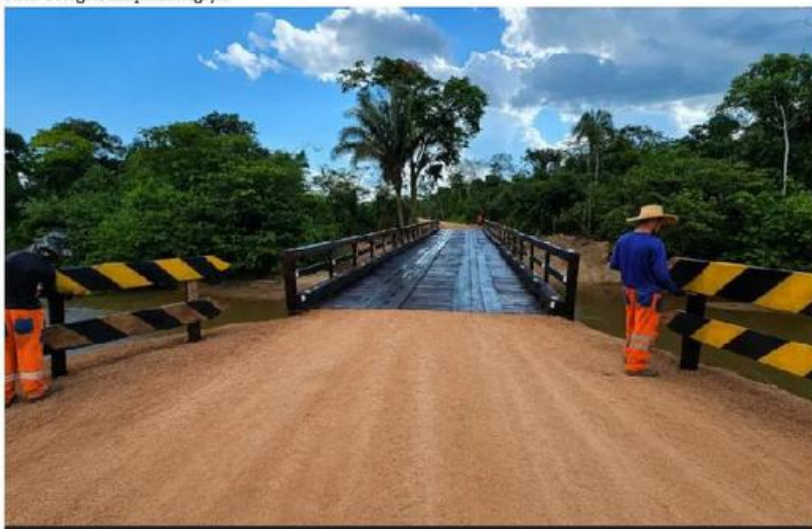
A ponte de madeira foi construída sobre o rio Novo Mundo, na RO-267, no trecho entre a BR-429 e a RO-010
