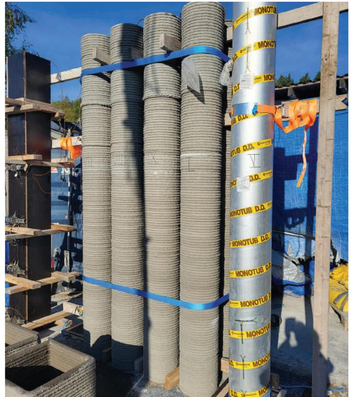
Fig. 1: Moldes de 3DPC y cartón antes del colado del SCC. Un molde rectangular de 3DPC es visible en la parte inferior izquierda de la imagen. Este molde fue utilizado para permitir la extracción de los núcleos de concreto para las pruebas subsecuentes de durabilidad.
