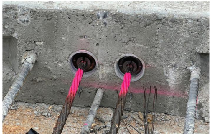
Fig. 1: Torones marcados con pintura con cuñas desasentadas antes de tensar.
