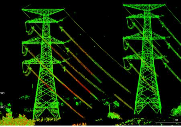
Elektrik iletim hatlarının uçuşa yasak bölgelerinde hassas tarama
