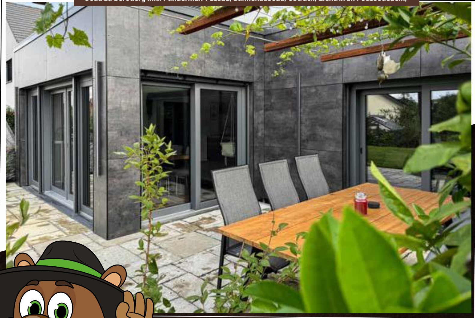
Ubau zu Berbuerg inkl. Fundermax-Fassad, Bannenausbau, Ustrach, Elektrik an Foussbuedem,
