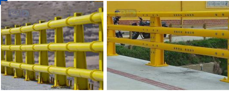
Barandillas de contención
