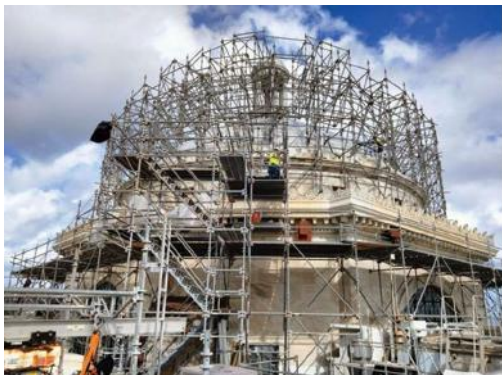
Cúpula del Capitolio de Puerto Rico durante su restauración
