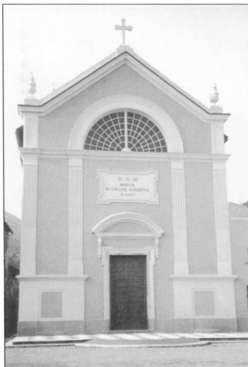
Masone (GE): Facciata della chiesa di S. Maria Assunta
