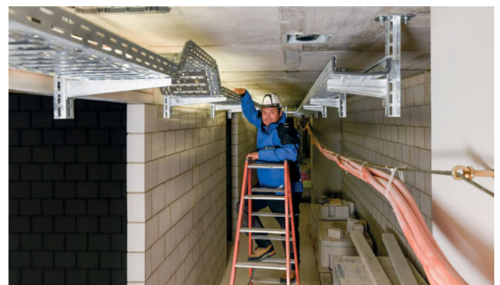
Als einer der beiden Bauleitenden Elektronistallateure, sorgte Adrian Bühler für eine koordinierte Umsetzung der Montagen.
