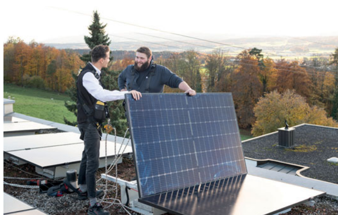
Flavio Kaufmann (links) informiert Armin über das spezielle bifaziale Glas-Glas-Photovoltaikmodul.
