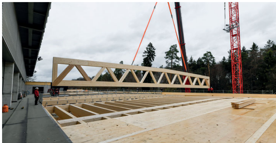
Das Vorschreiten der Holzkonstruktion, umgesetzt durch die Frischknecht Holzbau-Team AG, war sehr spannend.
