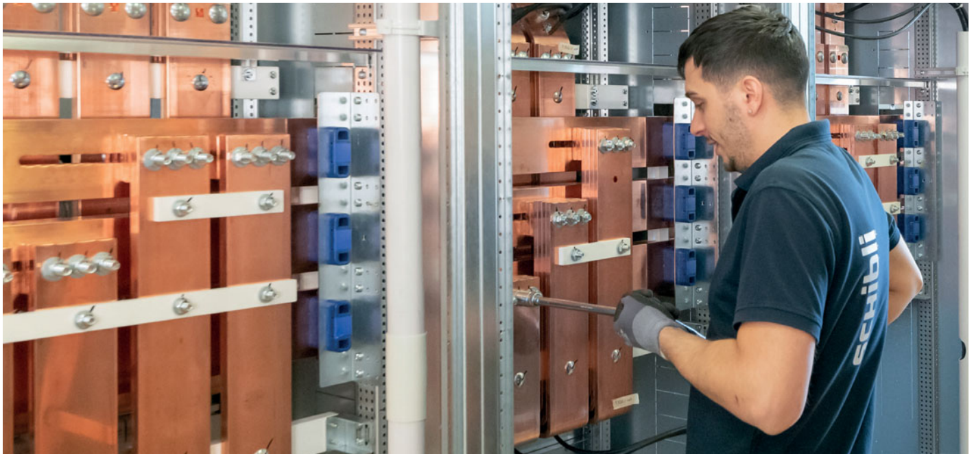
Domenico Grigoli bei der Montage einer VAMOCON Schaltschrankanlage in der Automatik-Werkstatt in Kloten.
