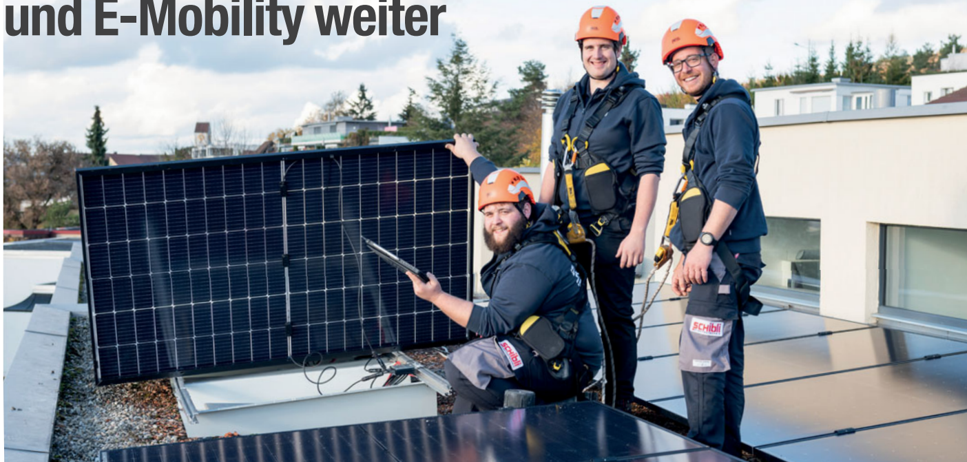
Armin Grossmann, Marco Käslin aus Uri und Michi Kaiser aus Zürich bei der Montage von 26 Photovoltaik-Panels auf dem Dach eines Einfamilienhauses. (v. l. n. r.)
