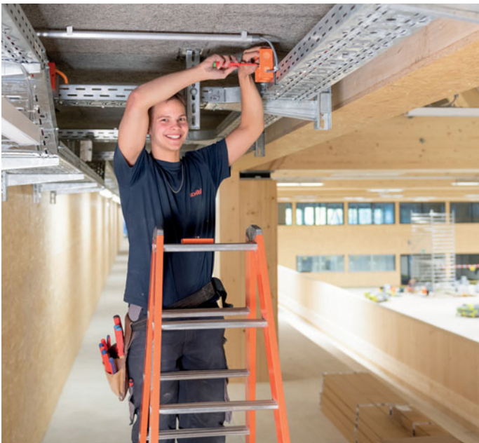
Gian Andri Candrian installierte unter anderem im Tribünenbereich die Brandschutzdosen.
