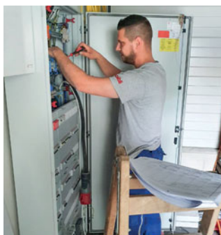
Christian Schmidt oben beim Anschliessen der Hauptverteilung, unten bei der Endkontrolle der Installationen kurz vor Projektende.
