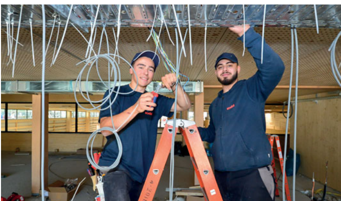
Silvan Camenisch und Raman Taher verlegen Kabel im Gastrobereich. Foto: Daniel Jaggi
