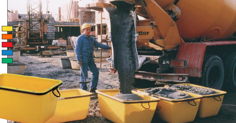
Mörtelkübel mit Tragebügeln, für die Arbeit mit dem Kran geeignet
