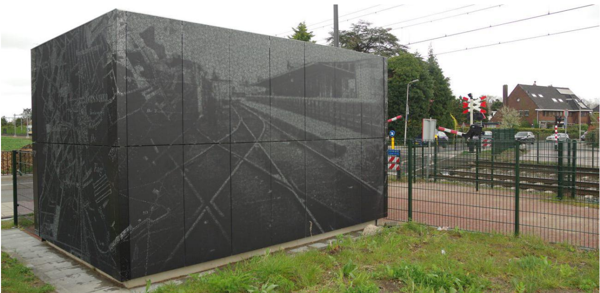
De zonnepanelen zijn voorzien van een print en zorgen als gevel voor de expressie van het gebouw, ontwerp technisch gebouw Naarden-Bussum (ontwerp UNStudio/Solar Visuals.)
