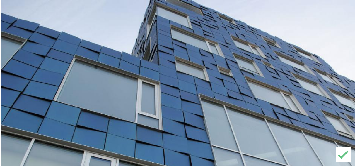
De zonnepanelen vormen met verschillende blauwtinten een compositie die deel uitmaakt van het gevelontwerp (International school Copenhagen, C.F. Møller)
