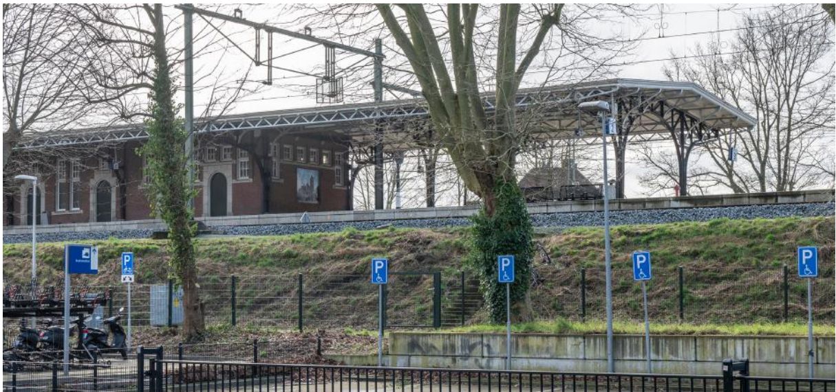
Aanzicht perron vanuit omgeving. Vanwege de ligging op een verhoogd spoordijklichaam is het zicht op het dak minimaal vanuit de omgeving op maaiveld. Station Weert.
