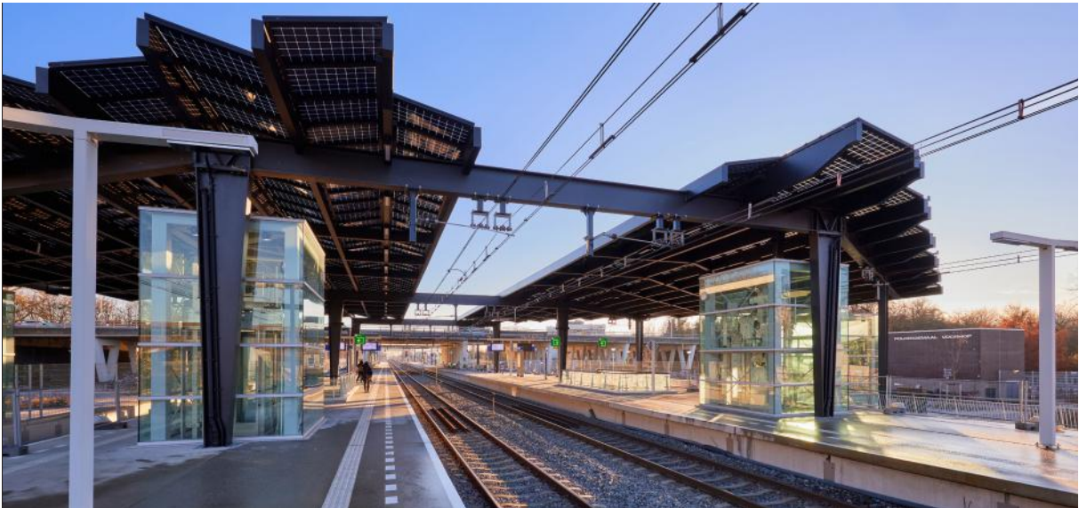
De zonnepanelen maken integraal deel uit van het ontwerp en vormen de dakbedekking, station Delft Campus (ontwerp Benthem Crowell Architects).
