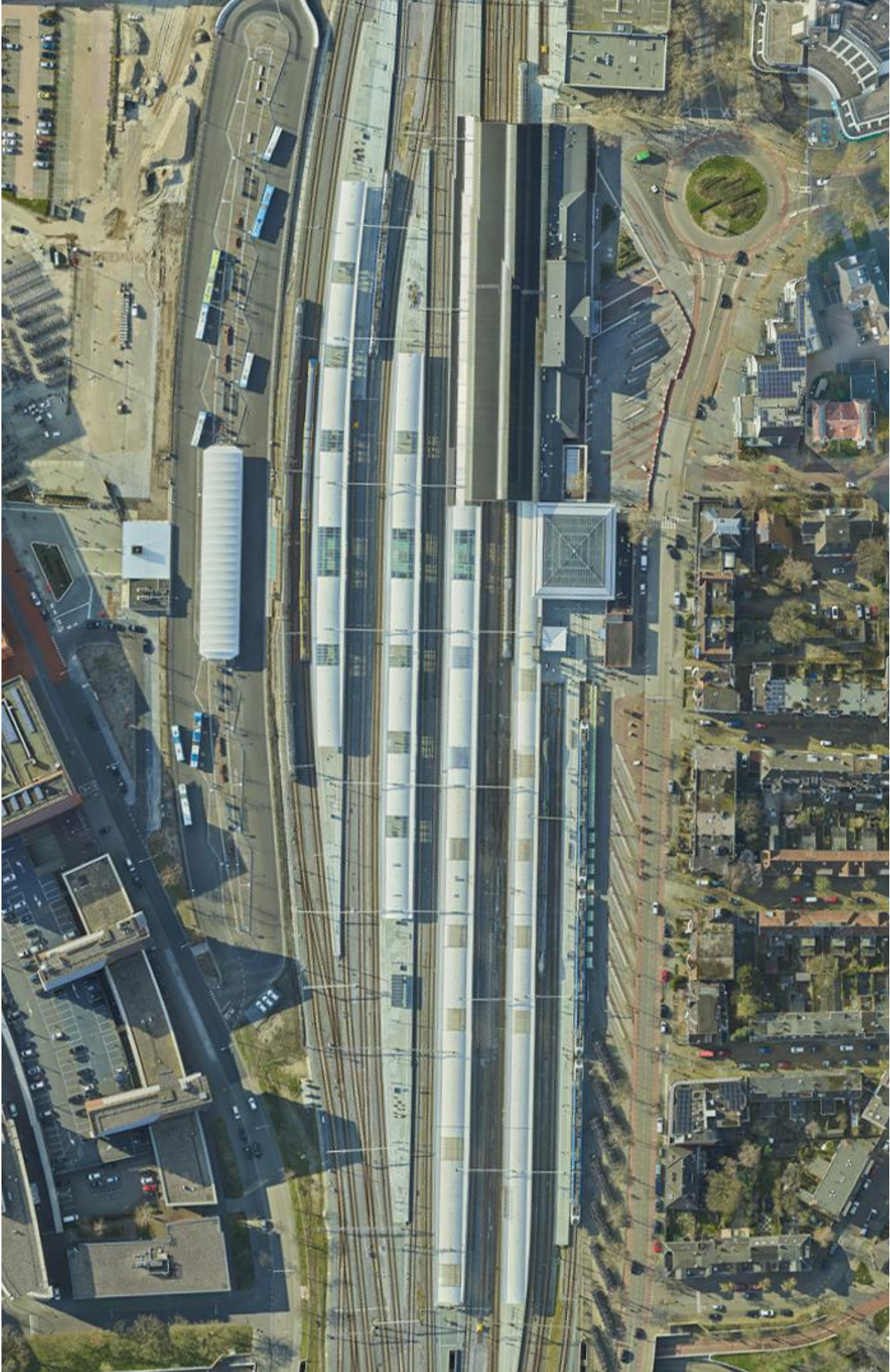
Luchtfoto station Zwolle; op de foto zijn de zonnepanelen nog niet geplaatst.
