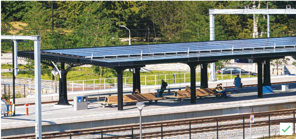
De panelen liggen terug van de rand en volgen de dakhelling. Station Driebergen-Zeist (ontwerp: Arcadis)
