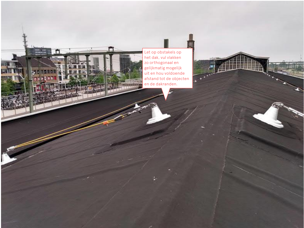
Huidige dak van de perrons heeft een bitumen dakbedekking
