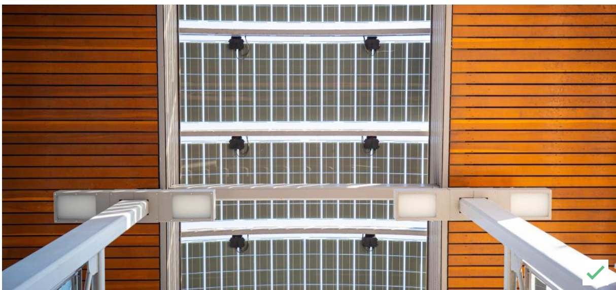
Bij inpassing in een bestaande situatie is het niet altijd mogelijk om de installaties uit het zicht te houden. Houd dan rekening met de zichtafstand. In dit voorbeeld zijn de omvormers klein en verstoren ze het beeld van de kap niet doordat ze in een ritme zijn geplaatst, station Utrecht Zuilen.
