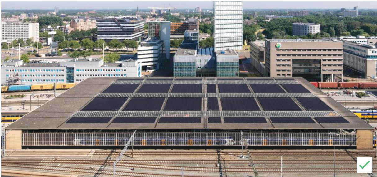
Een samenhangend vlak met vier gesloten randen, het vlak opknippen in twee of meerdere vlakken vanwege obstakels, station Eindhoven (ontwerp Arcadis)
