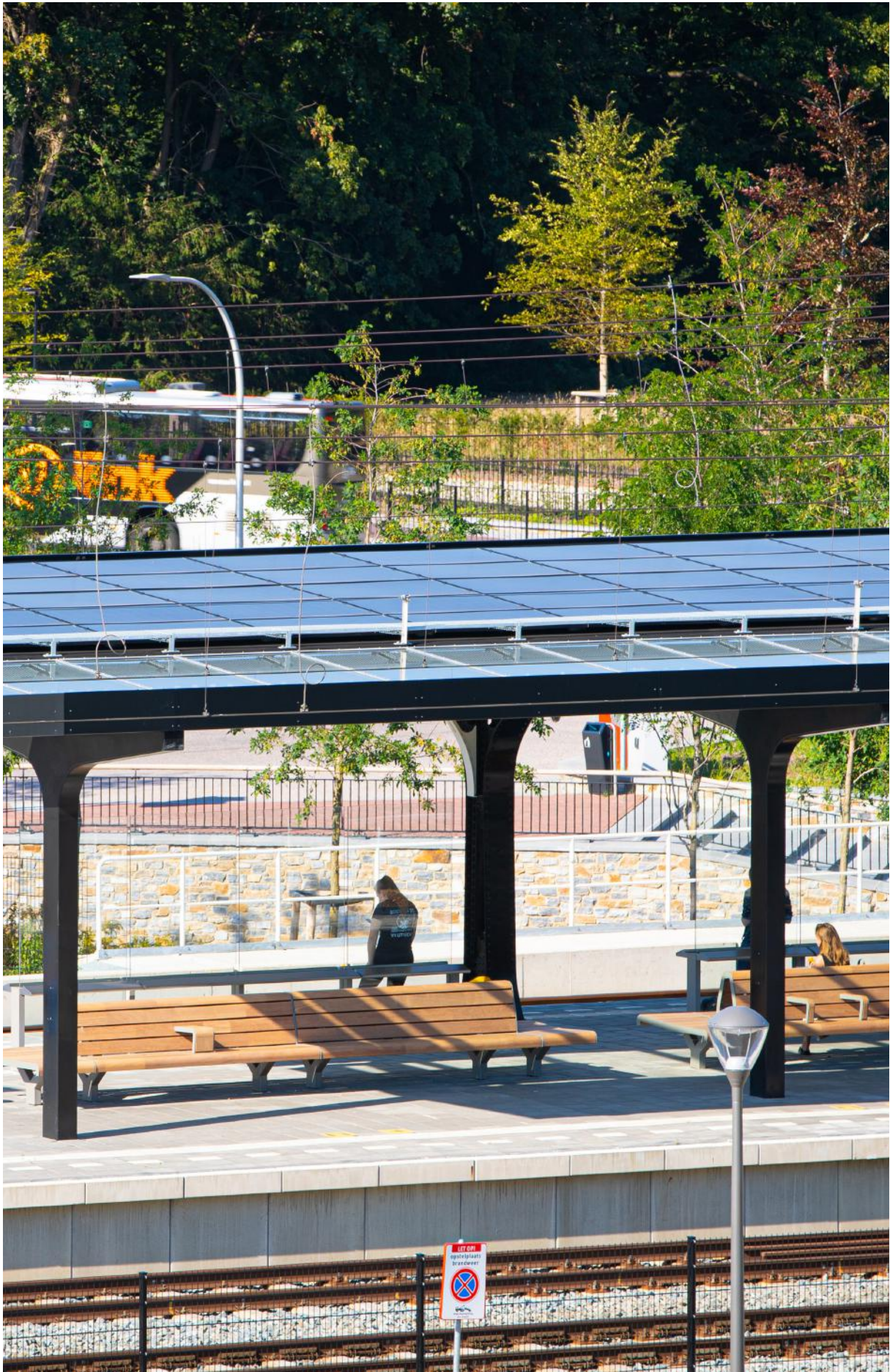
De panelen van het zonne-energiesysteem volgen de vorm van de perronkap, station Driebergen-Zeist.
