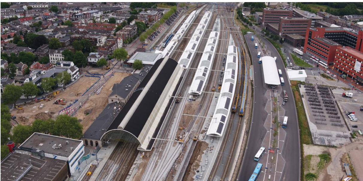
Zonnepanelen tussen de lichtstraten op station Zwolle.
