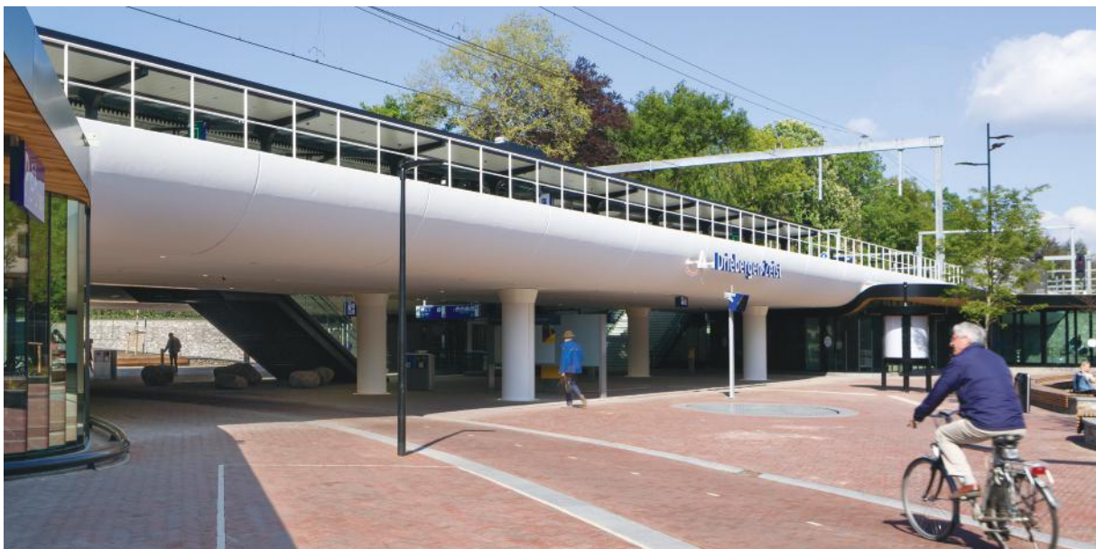
Vanaf het openbaar terrein is het zonne-energiesysteem op de perronkap niet zichtbaar, station Driebergen-Zeist.
