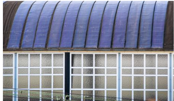
Dunne film dient zorgvuldig ingepast te worden zodat geen slordige afwerking ontstaat dat afbreuk doet aan de kwaliteit en monumentale uitstraling.
