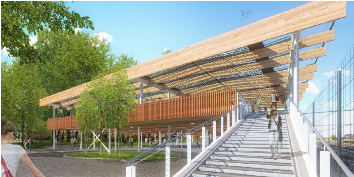
Visualisatie secundaire entree; fietsenstalling station Dordrecht. De schaduw van monokristallijne cellen in het glas is duidelijk zichtbaar op de dakconstructie.
