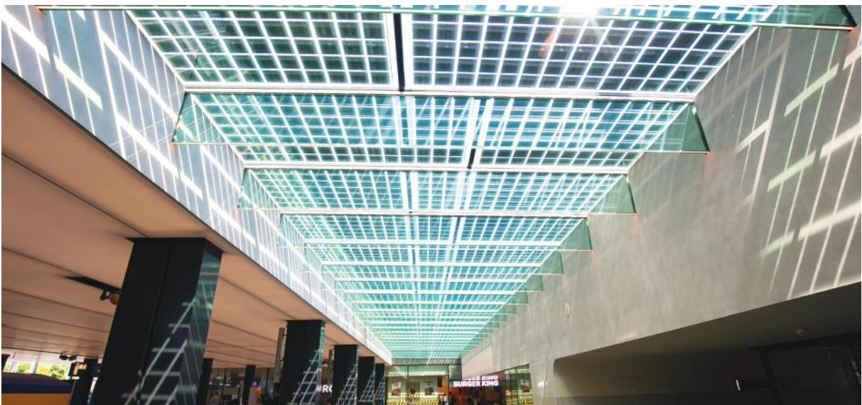
De lichtstraat bij de entree zorgt voor een lichte hal waar tegelijkertijd energie wordt opgewekt. De monokristallijne cellen zijn gelijk verdeeld waardoor een egale slagschaduw ontstaat die niet storend is. Het is een verbijzondering van de hal. Station Eindhoven (ontwerp Arcadis)
