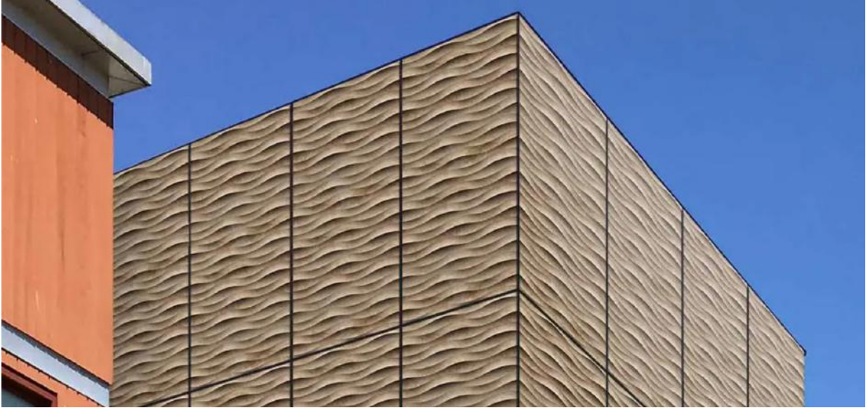
Bedrukt zonnepaneel waardoor het beeld van een textuur ontstaat. Voorbeeld: Solar Visuals
