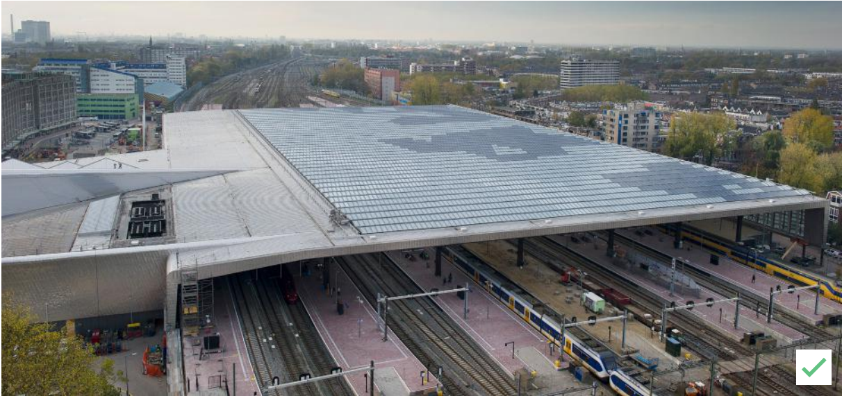
Bij het ontwerp van het zonnepaneel is het bovenaanzicht van het dak verbijzonderd, station Rotterdam Centraal.
