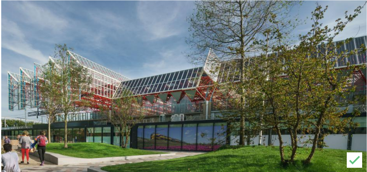
Transparante zonnepanelen passen in de High-tech architectuurstijl station Almere Centrum
