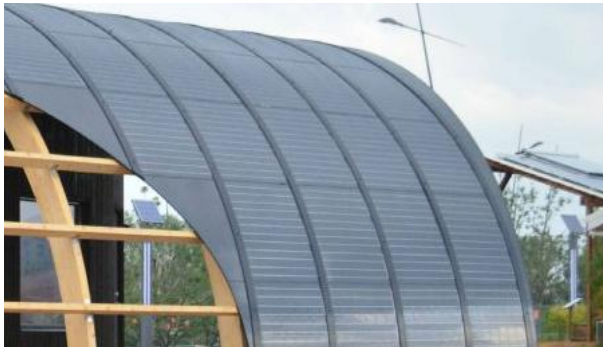
Flexibele panelen kunnen netjes de dakvorm volgen. Deze panelen hebben minder rendement dan reguliere panelen.
