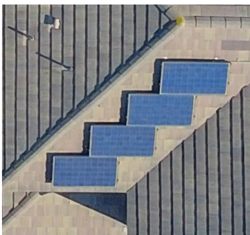
Maak geen rafelrand, bijvoorbeeld op afgeschuinde vlakken.
