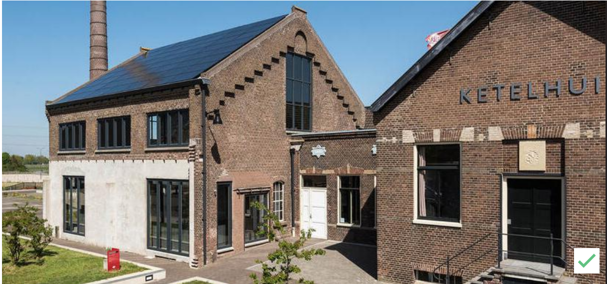
Het zonnestelsysteem is een integraal onderdeel van het ontwerp. Het dakvlak is maximaal benut en de panelen lopen door tot de nok. De panelen sluiten netjes aan op de bestaande helling van het dak, de uitstraling van het gebouw en de detaillering, ketelhuis Ulft.
