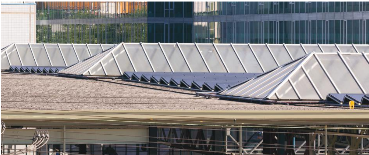
Zonnepanelen tussen de lichtstraten op station Eindhoven.
