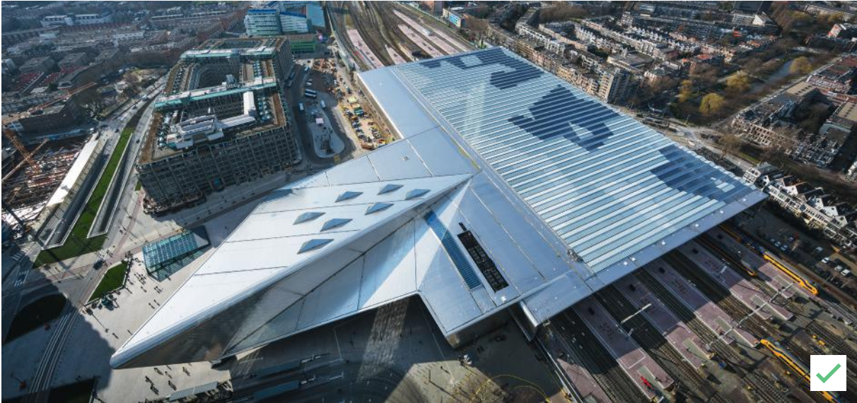
De combinatie van zonnepanelen en patronen op de glaskap zorgen samen voor een bijzonder dak, kunstwerk op station Rotterdam Centraal.
