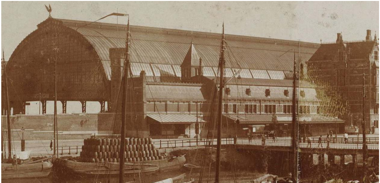
Historisch beeld van de stoomkappen waarin de geleiding duidelijk zichtbaar is die werd veroorzaakt door de zinken stroken. Station Amsterdam Centraal.
