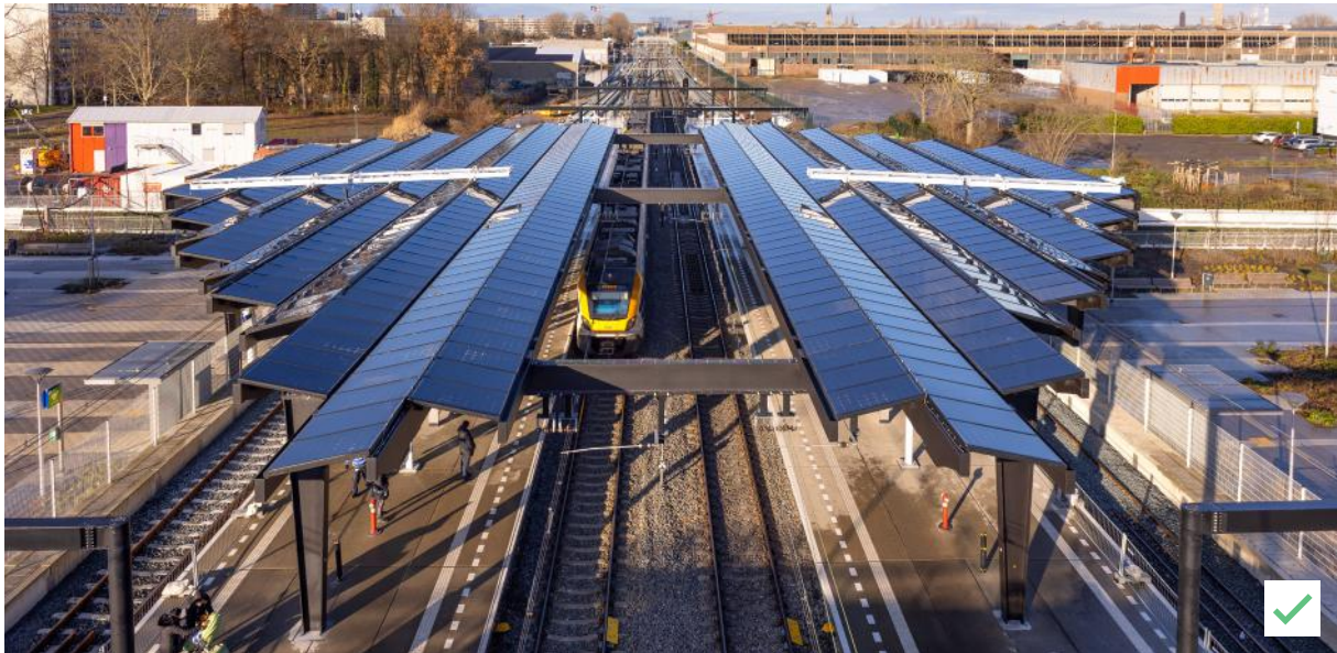
Het zonnestelsysteem vervangt de dakconstructie én de dakbedekking, station Delft Campus (ontwerp Benthem Crouwel Architects).
