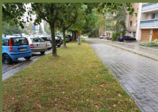
POTENCIÁL PRO SVÁDĚNÍ SRÁŽKOVÉ VODY Z CHODNÍKU DO PRŮLEHU V ZELENÉM PÁSU
