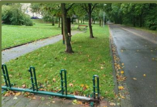
POTENCIÁL PRO SVEDENÍ SRÁŽKOVÉ VODY DO ZELENÉHO PÁSU PROŘEZÁNÍM OBRUBNÍKU
