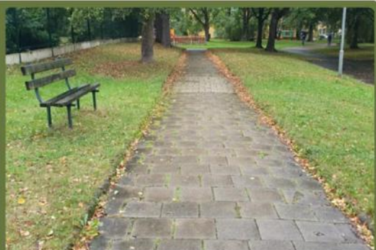
POTENCIÁL PRO SVEDENÍ SRÁŽKOVÉ VODY DO ZELENÉHO PÁSU PROŘEZÁNÍM OBRUBNÍKU
