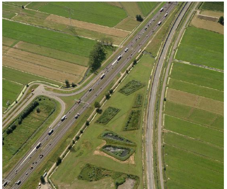
Bij losse bundeling worden ad hoc invullingen tussen de samenstellende infrastructuur zo veel mogelijk vermeden (Sliedrecht).
