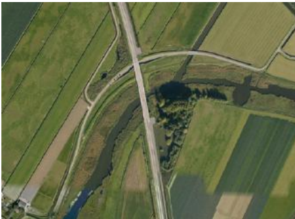
HSL doorsnijdt de Devel in zeekleipolder bij Zwijndrecht.
