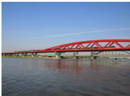
De nieuwe spoorbrug in de Hanzelijn bij Zwolle .
