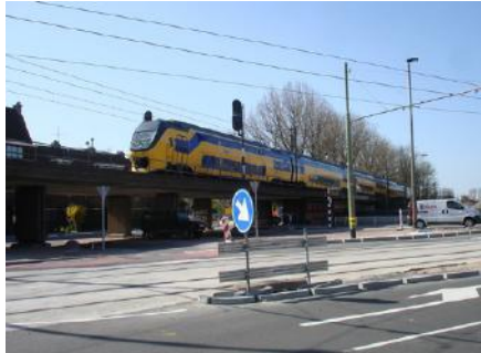
Het spoorviaduct in Delft
