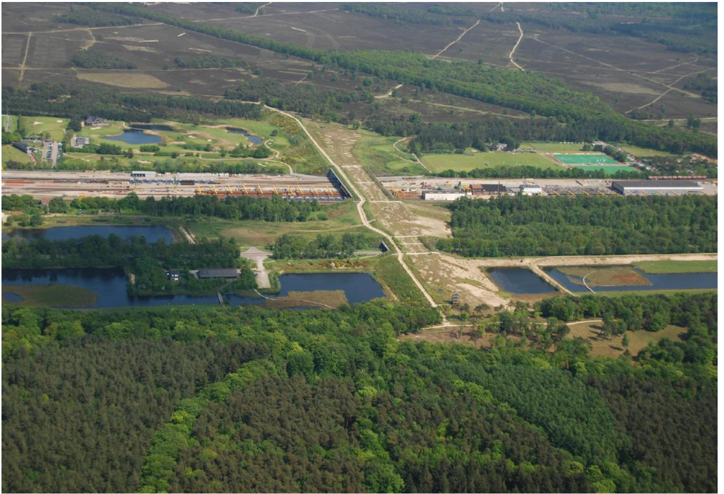
Natuurbrug over de stapelplaats van Railpro bij Crailoo. Eén van de langste gebouwde ecologische verbindingen van Europa.
