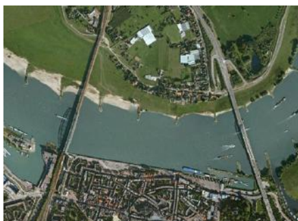
Spoorbrug en verkeersbrug over de Waal bij Nijmegen.
