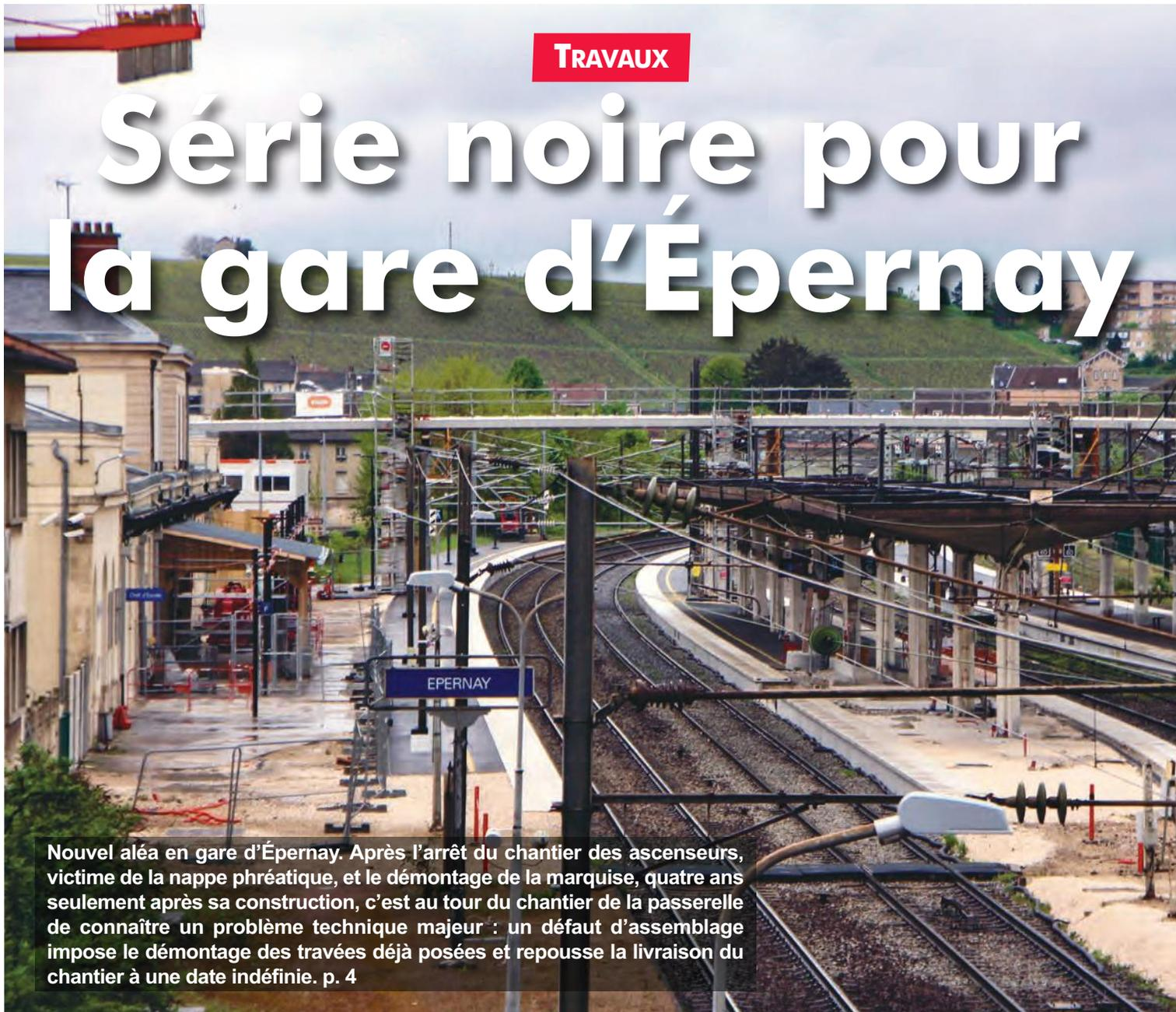
Nouvel aléa en gare d'Épernay. Après l'arrêt du chantier des ascenseurs, victime de la nappe phréatique, et le démontage de la marquise, quatre ans seulement après sa construction, c'est au tour du chantier de la passerelle de connaître un problème technique majeur : un défaut d'assemblage impose le démontage des travées déjà posées et repousse la livraison du chantier à une date indéfinie. p. 4
