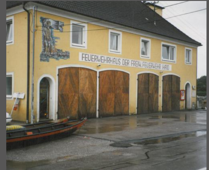
Feuerwehrhaus nach Umbau 1981 / Foto nach Hochwasser 2002
