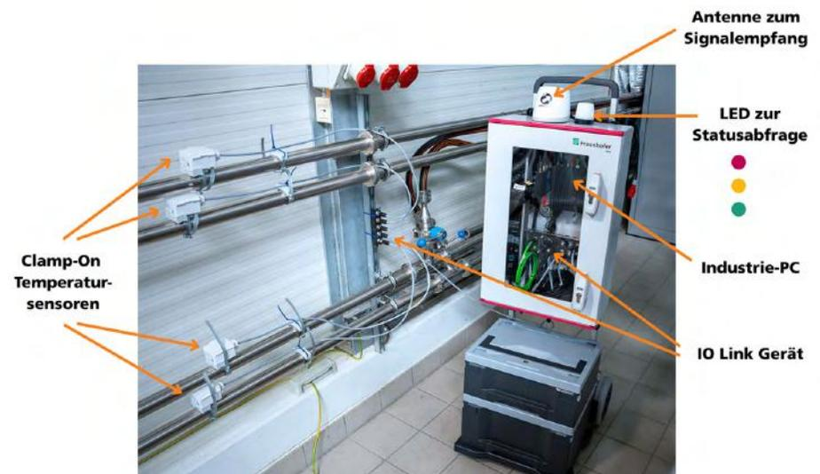
**Bild 1: Aufbau des Systems zur Foulingvorhersage**
