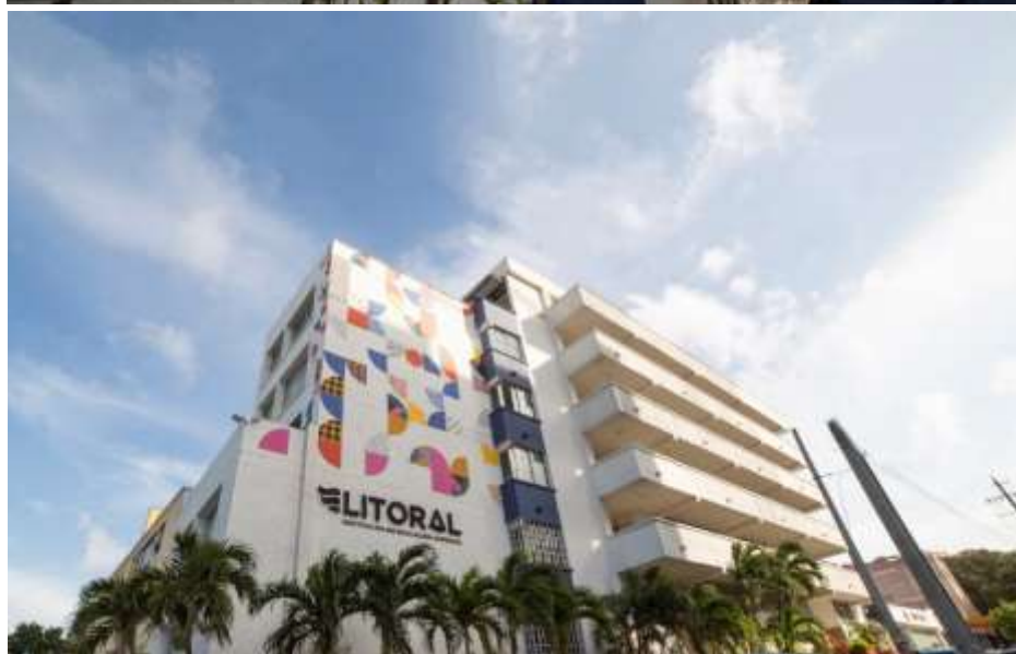
Ilustración 35. Fachada de la Corporación Educativa del Litoral Edificación 1.
