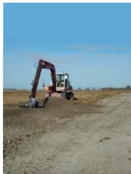
Csatornabetemetés Apajpusztán. Fotó: Vajda Zoltán
