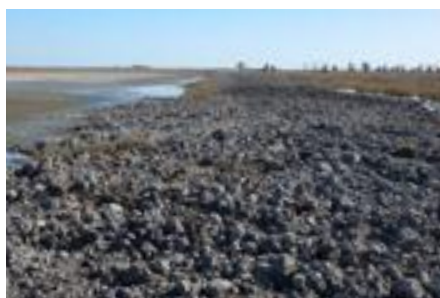
Az elbontott töltés nem akadályozza többé a víz áramlását. Fotó: Vajda Zoltán
