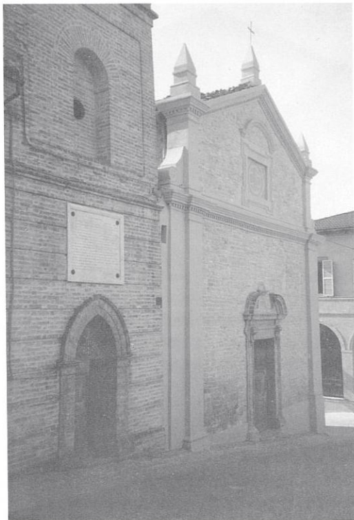
Monte S. Martino: Facciata della chiesa
