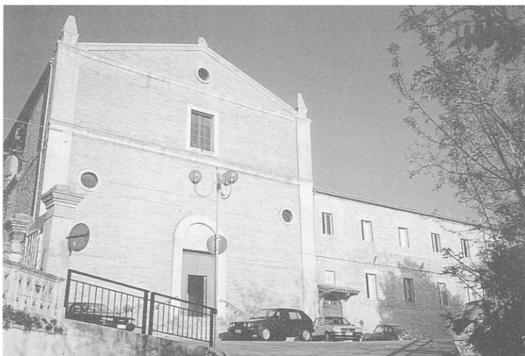
Acquaviva Picena: Facciata della chiesa e del convento
