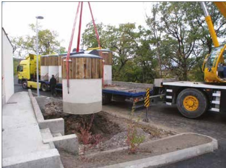
Colocação dos Tiërsos em Gap (França). Após o fecho do ponto de escavação o sistema está pronto a ser utilizado.
