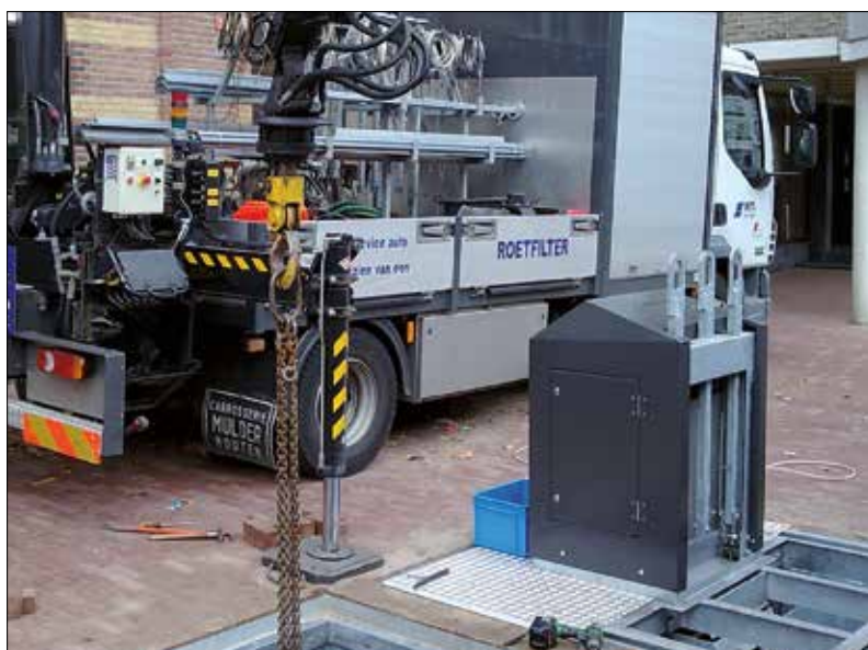
Colocação de contentor com sistema de pressão em Koninginnewal, Helmond (Holanda).
