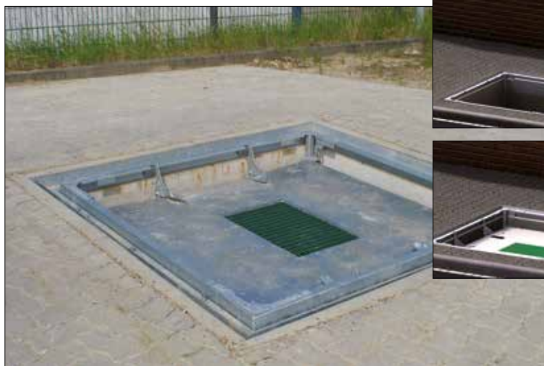
Plataforma de segurança, como alternativa à proteção de segurança normal.
