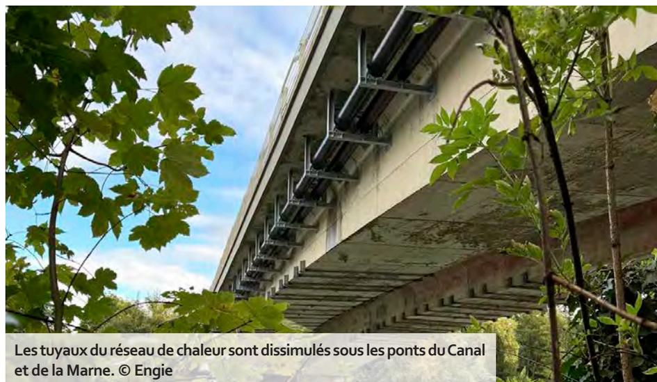
Les tuyaux du réseau de chaleur sont dissimulés sous les ponts du Canal et de la Marne. © Engie
