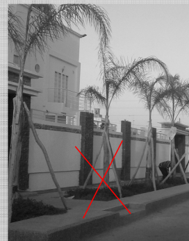
empiètement excessif des jardinières
