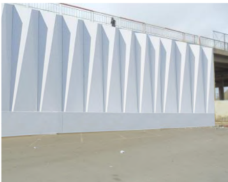
Traitement en peinture nuancée
