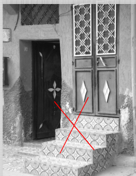
saillies sur trottoir à éviter
