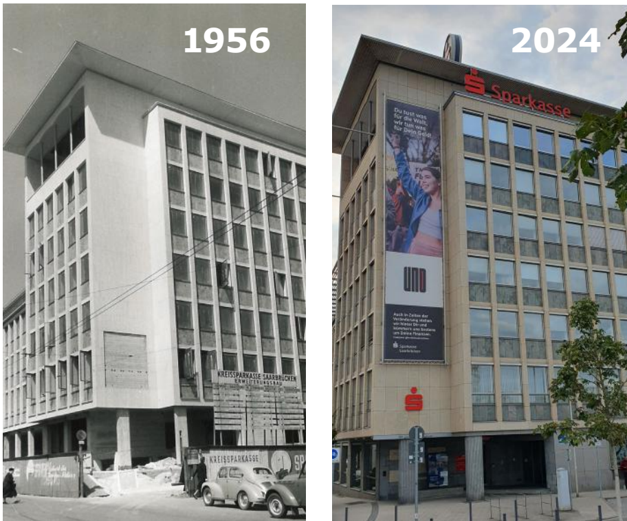
Bild 22: Mit Sulfathüttenzement „Halit“ der Halberger Hütte gebaute Kreissparkasse Saarbrücken
